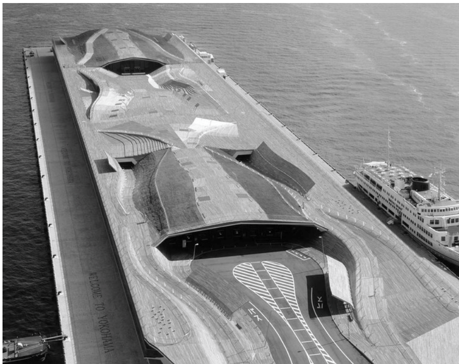
Fig. 5: Terminal de Pasajeros de Yokohama. FOA
