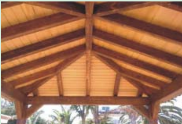
Estructura de techo
