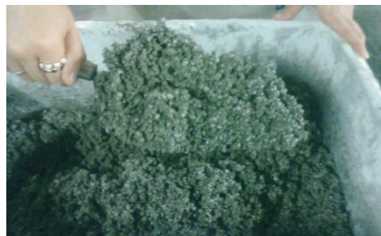
Figura 1. Preparación de Hormigón con EPS
