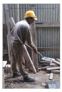
La posición cómoda del levantamiento de la carga sobre la pala requiere 1,05 metros, que son unos 15 cm más que el diámetro del pozo. Es decir, que el movimiento se ve limitado por el espacio de trabajo y genera una incomodidad en la realización de la tarea.
