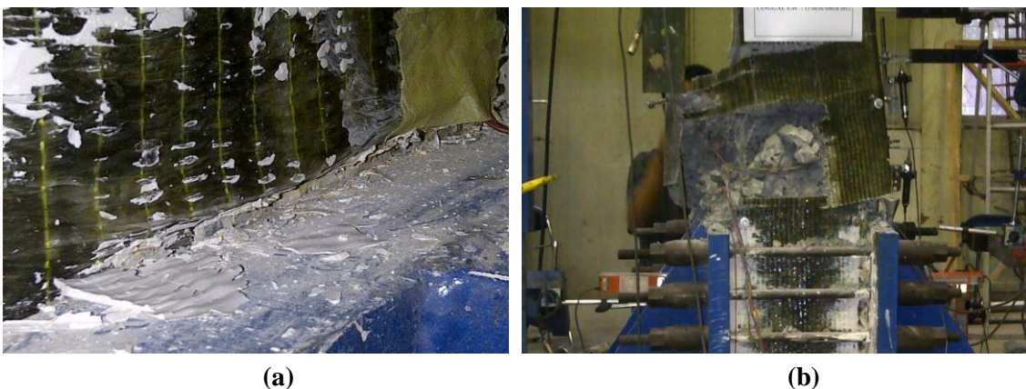
Gambar 9. Kolom C-1RG: (a) Retak pada Daerah Sendi Plastis, (b) Retak dan Spalling pada Ujung Kepala Kolom
