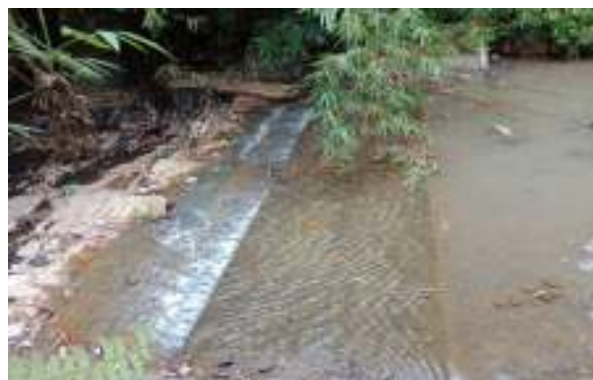
Gambar 6 Kondisi Sabo Dam Kali Lumajang pada Bulan Juli 2019
