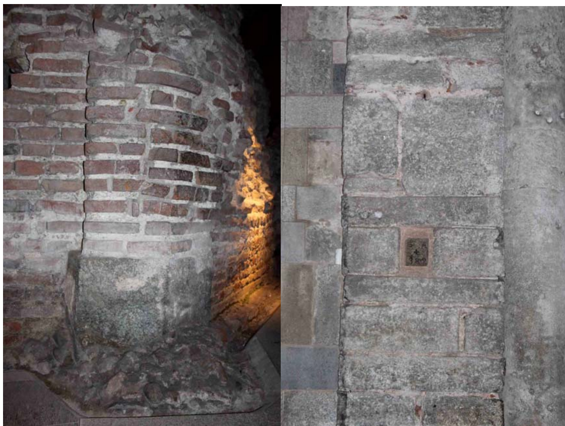
Figg. 4-5. Lesena SE del battistero di San Giovanni alle Fonti (fine IV sec. d.C.); particolare della tecnica dei pilastri di San Nazaro Maggiore (fine IV sec. d.C.).
