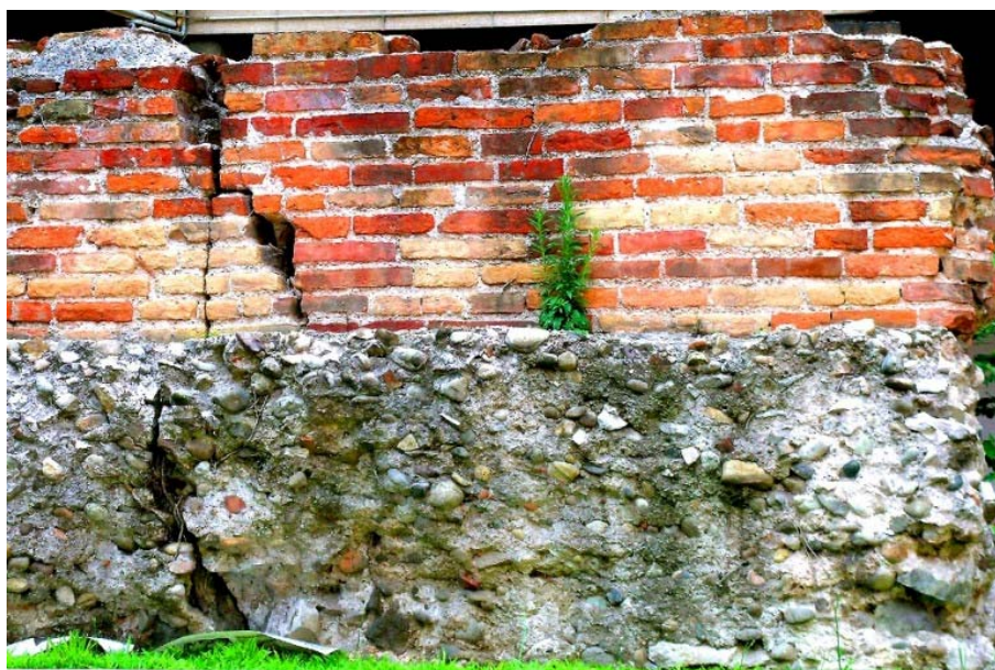
Fig. 1. Muratura in ciottoli che supporta una muratura in laterizio (Terme Erculee, lacerto riposizionato in Largo Corsia dei Servi).
