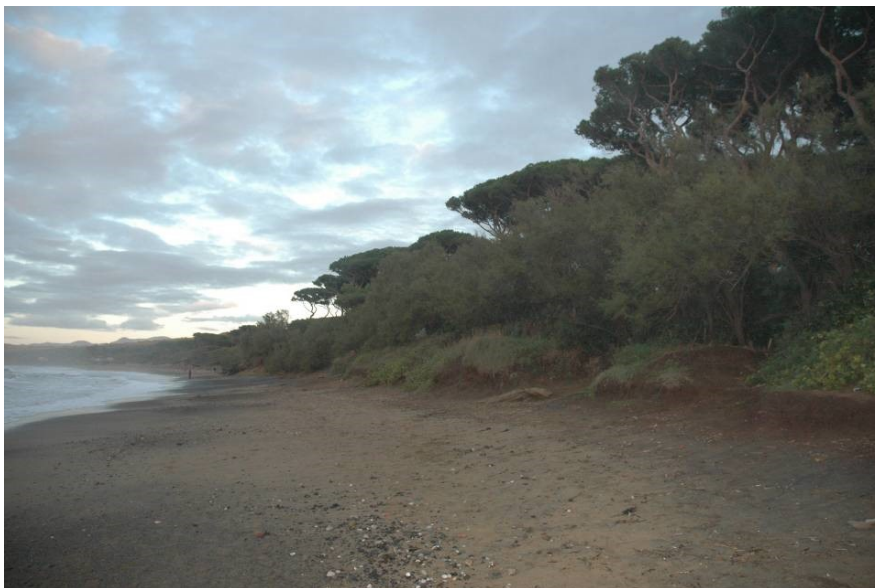
Fig. 2. Panoramica dell'area di scavo sulla spiaggia prima dell'inizio dei lavori.
