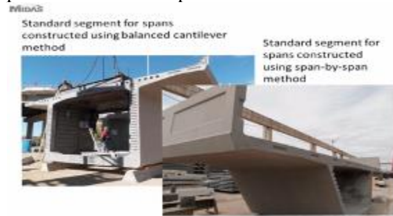
Gambar 1. Bentuk struktur box girder
