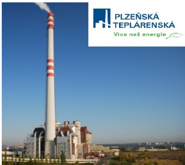
Figure 2 – Plzeňská teplárenská, a.s.
