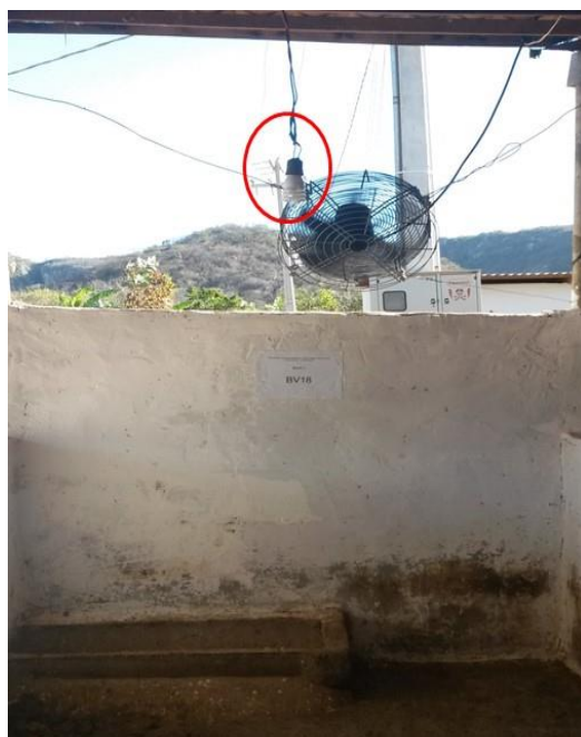
Figura 7. Disposição do sistema de iluminação no interior da baia.
