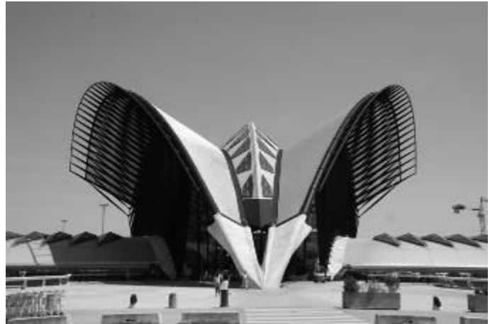
Gambar 1 Stasiun TGV karya Calatrava dengan Metafore Seekor Burung
