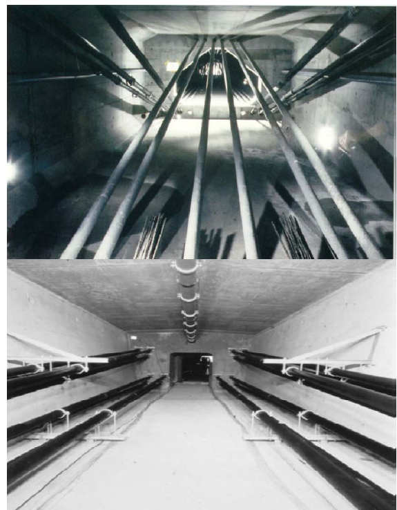
Gambar 1. Perkuatan dengan external prestressing reinforce pada jembatan box girder
