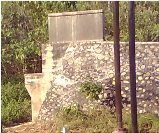
Gambar 4. Kondisi abutmen eksisting Jembatan Sumara
