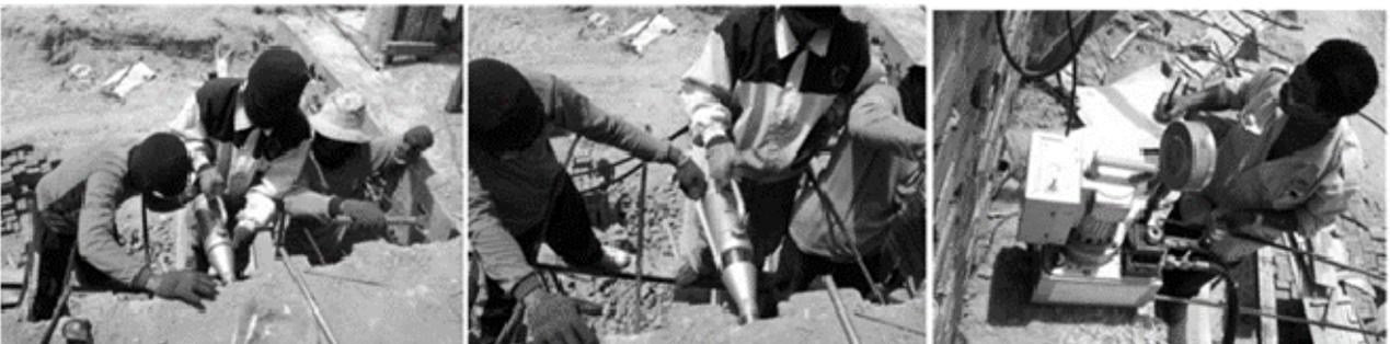
**Gambar 10.** Pekerjaan stressing (kiri), pengukuran *elongation strand* (tengah) dan pembacaan beban tarik pada manometer (kanan)
