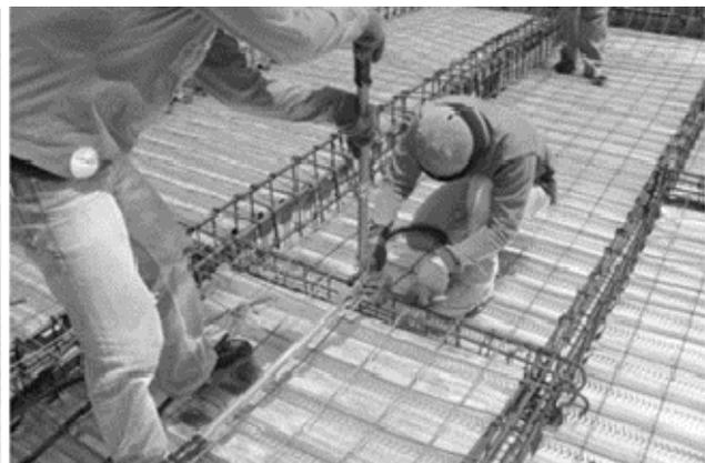
**Gambar 7.** Pekerjaan perancah untuk dudukan *icon steel* dan pemasangan *wiremesh*
