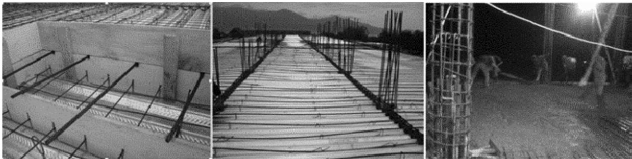
**Gambar 9.** Posisi angkur, pemasangan strand dan pekerjaan pengecoran
