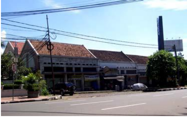
Gambar 2. Bangunan Rumah Toko Ekstensi Toko Singer dilihat dari Jalan Asia-Afrika. Bangunan berkonsep setback terhadap jalan raya (sumber: Dokumentasi Pribadi, 2010).
