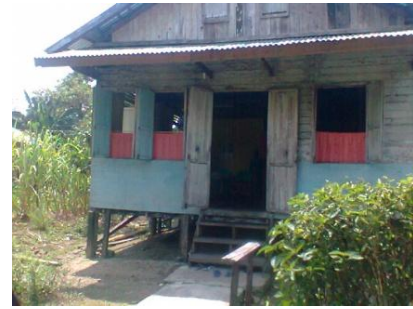
Gambar 2. Dinding rumah rakyat Kalbar yang diganti dari dinding papan (bagian atas) menjadi simpai (bagian bawah).
