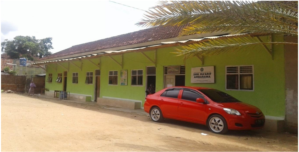
Gedung SMK Ma'arif Ambarawa Pringsewu
