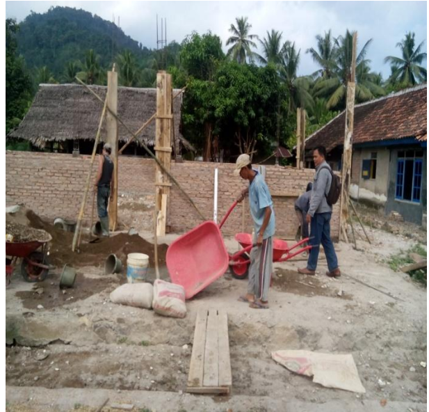
Pembangunan Balai Pekon Paku
