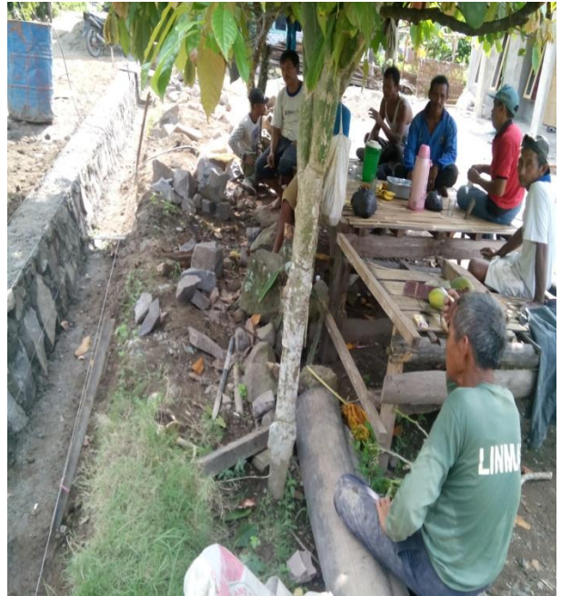
Pembangunan Drenase Pekon Paku
