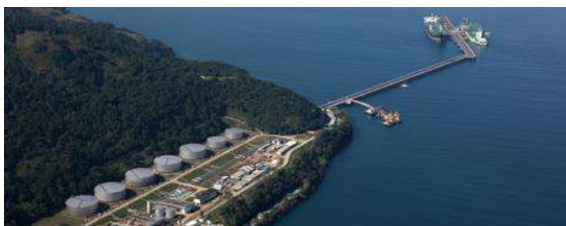
Figura 2:2:Terminal de Angra dos Reis Fonte: Petrobras (2015)
