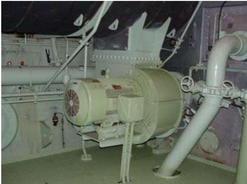
**Figura 3-9: Soprador Auxiliar**
