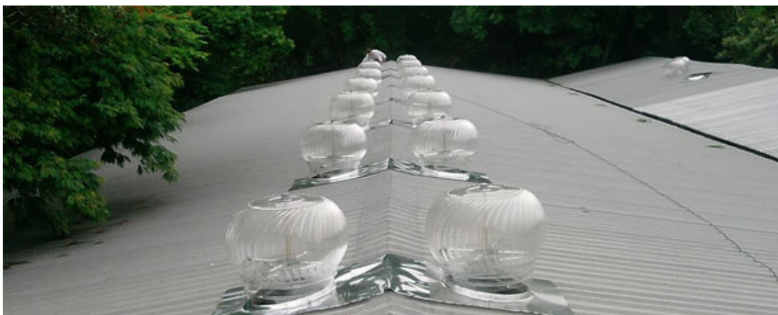
Figura 25: Exemplo de aplicação de exaustor eólico iluminador
