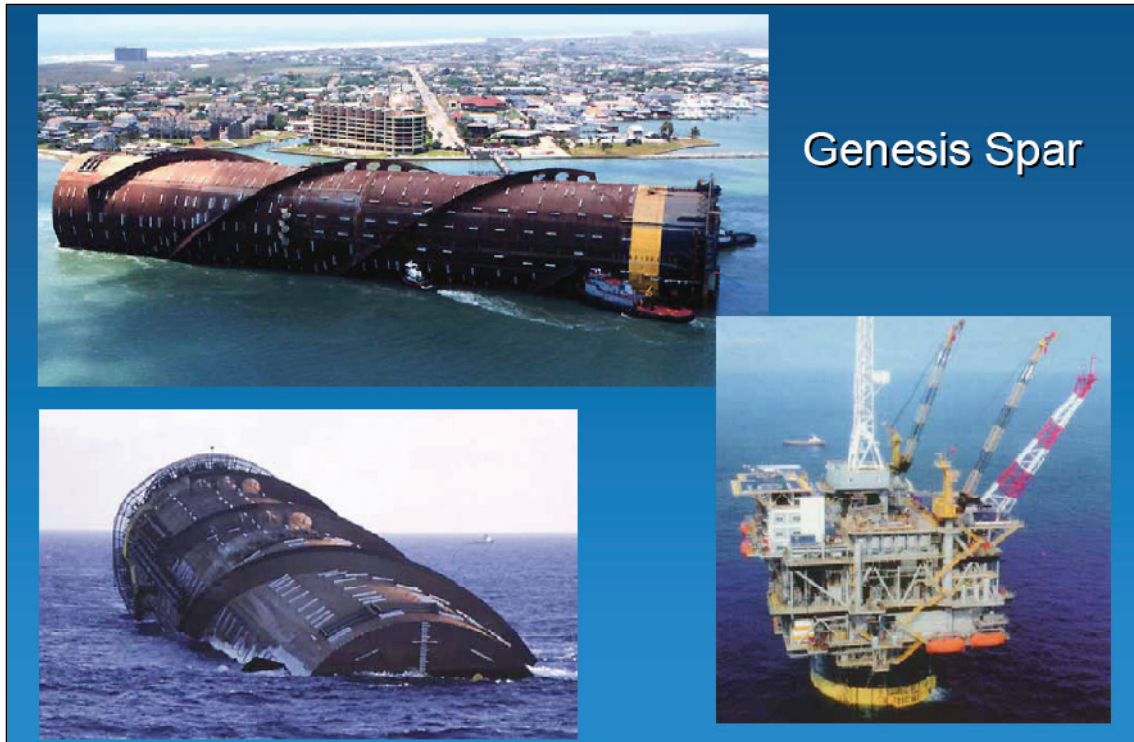
Figura II.17 – Plataforma Spar Buoy em operação e fases de instalação. (Ellwanger [34])
