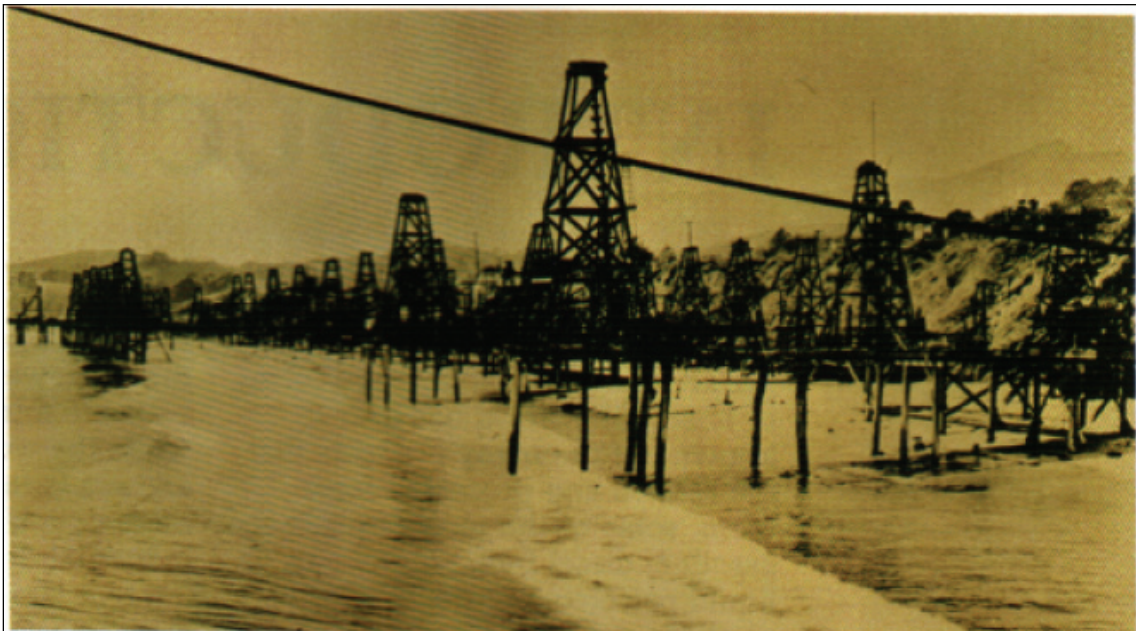
Figura II.3 – O primeiro poço offshore nos Estados Unidos foi perfurado próximo à Summerland, Califórnia, em torno de 1900. (Ellwanger [34])
