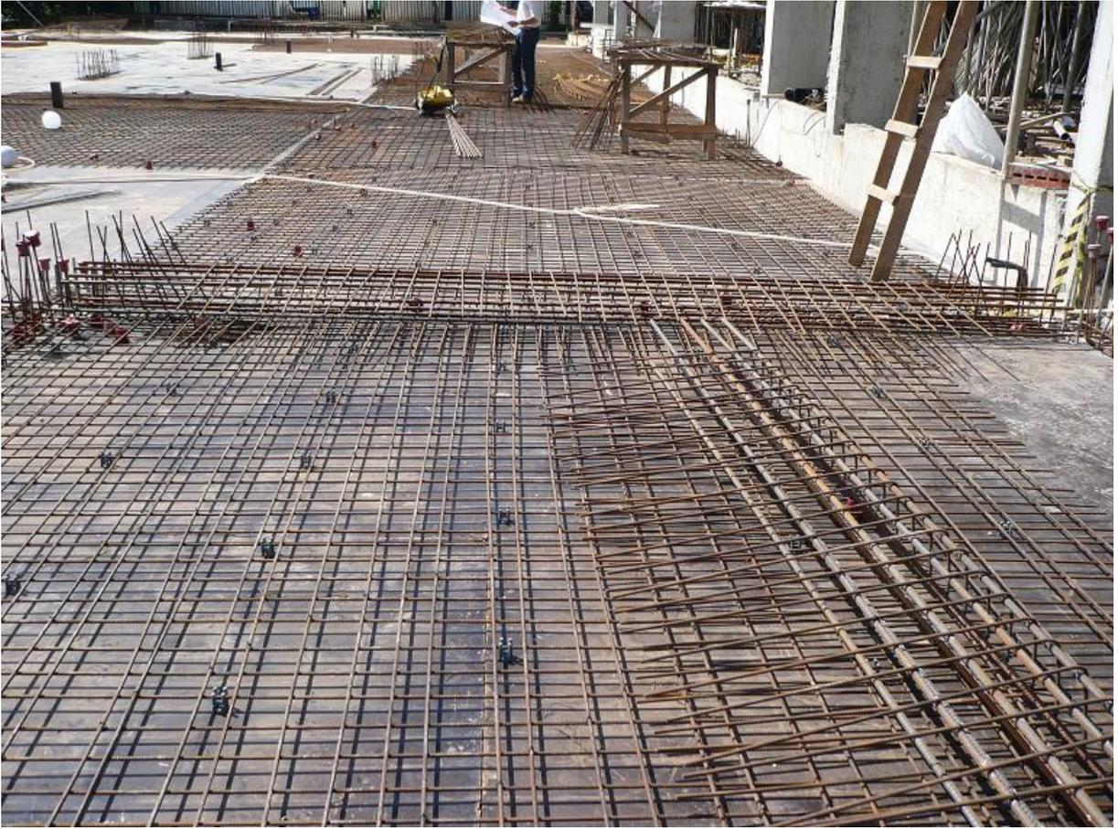
Figura 4.1 – Montagem das malhas de aço
