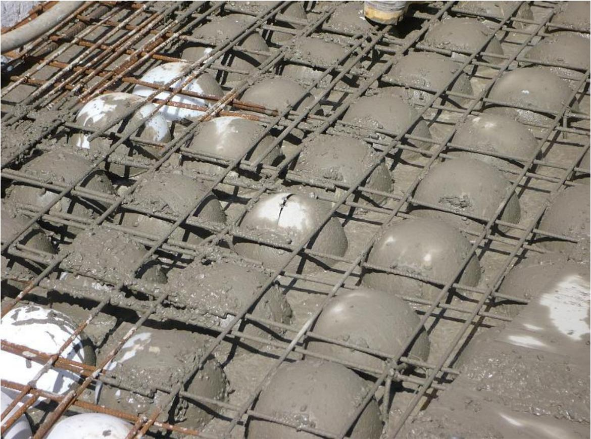
Figura 4.11 – Detalhe de erro de concretagem
