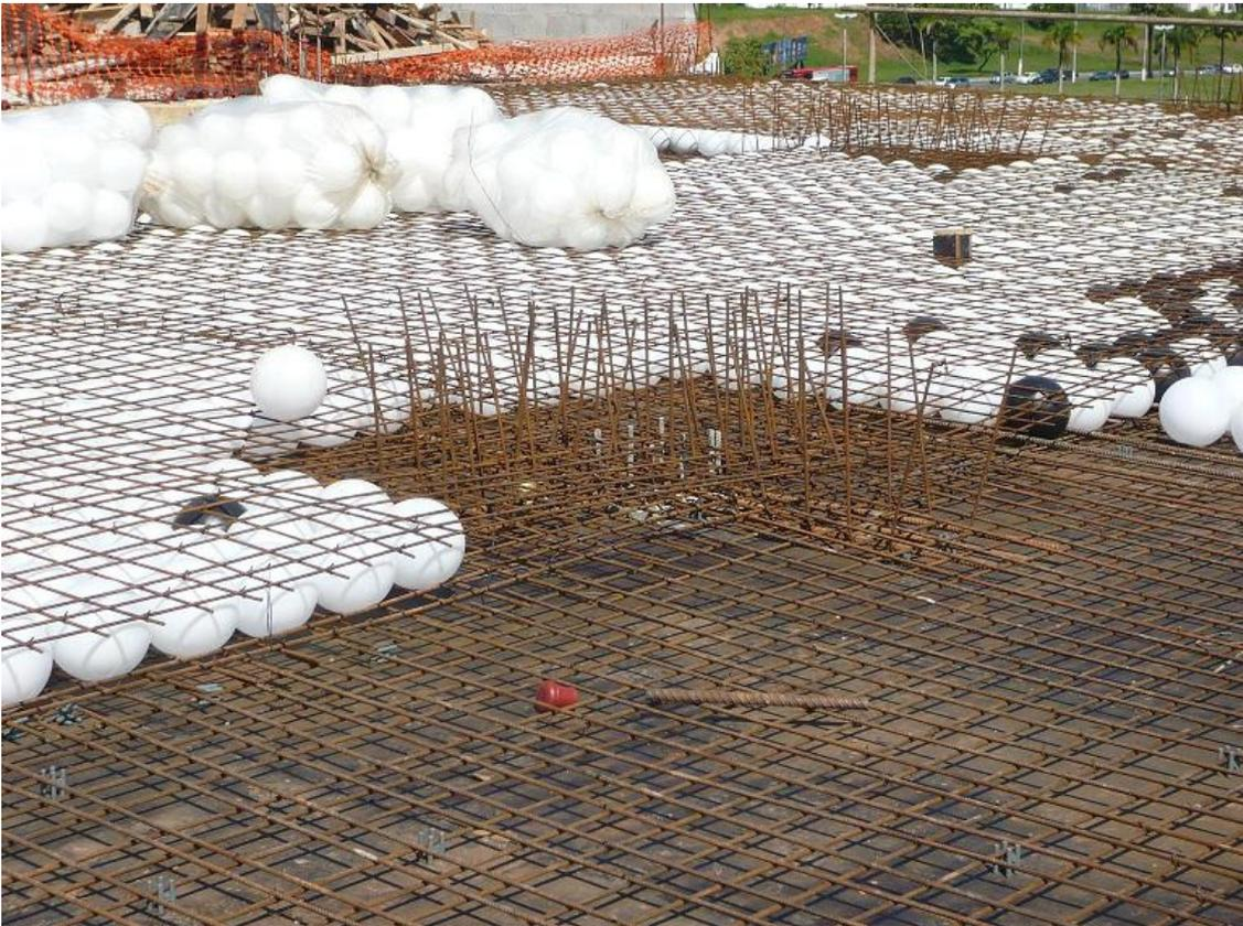
Figura 4.2 – Montagem das esferas
