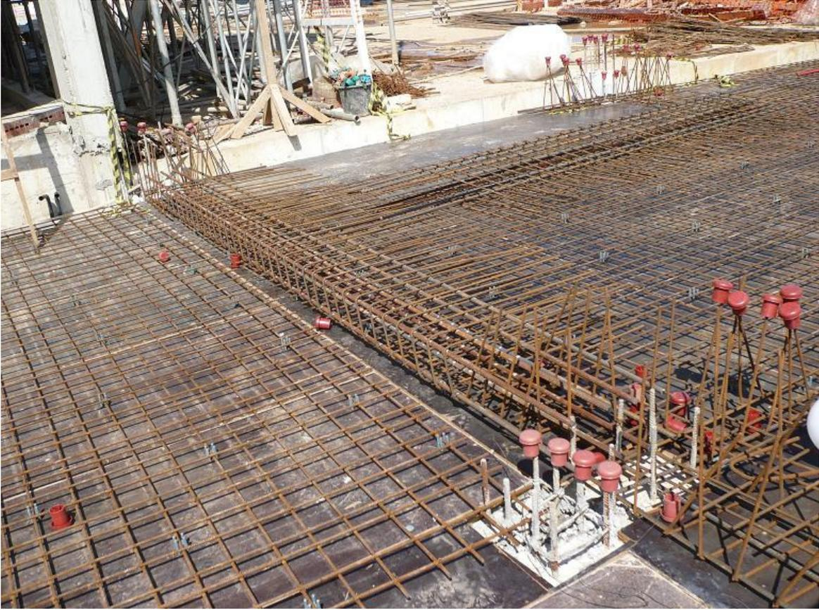
Figura 4.5 – Detalhe da junta de ligação entre os dois setores
