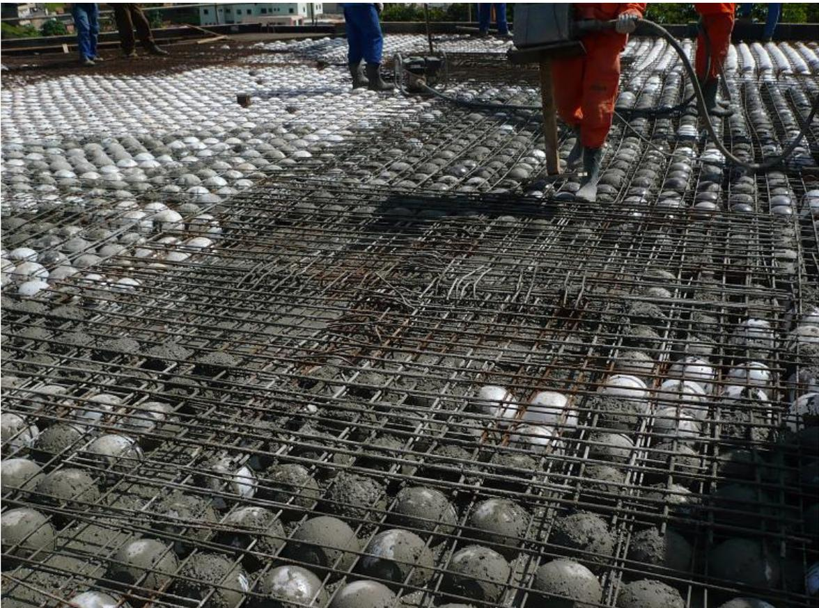
Figura 4.6 – Concretagem e armadura do capitel
