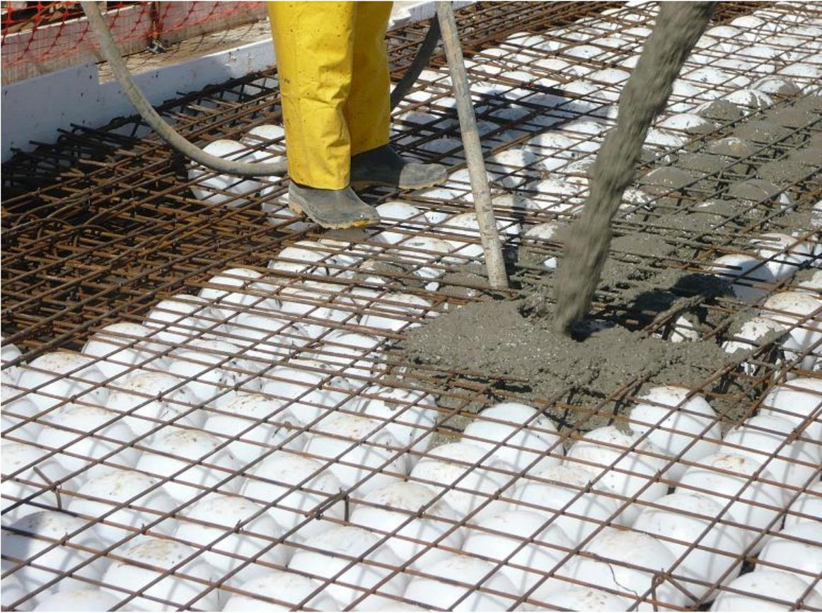
Figura 4.7 – Concretagem
