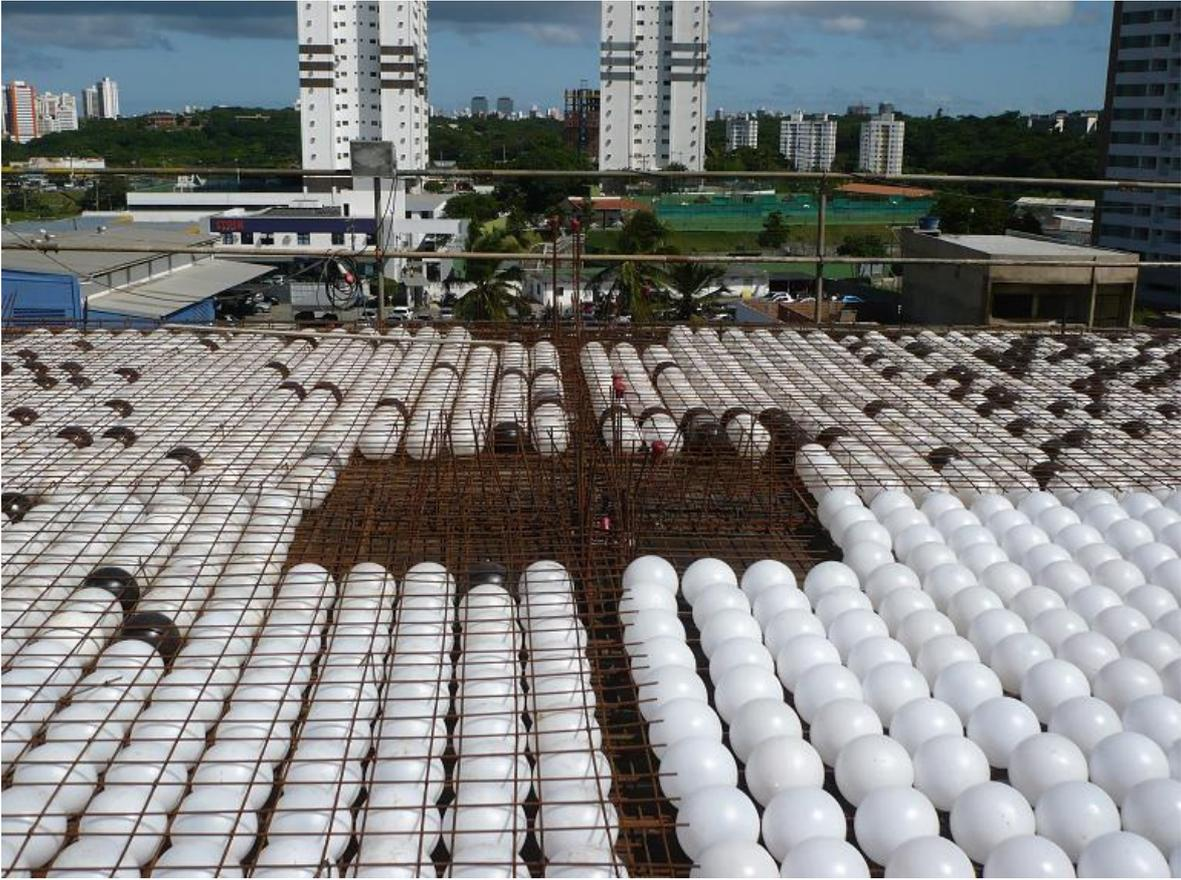
Figura 4.3 – Montagem das esferas
