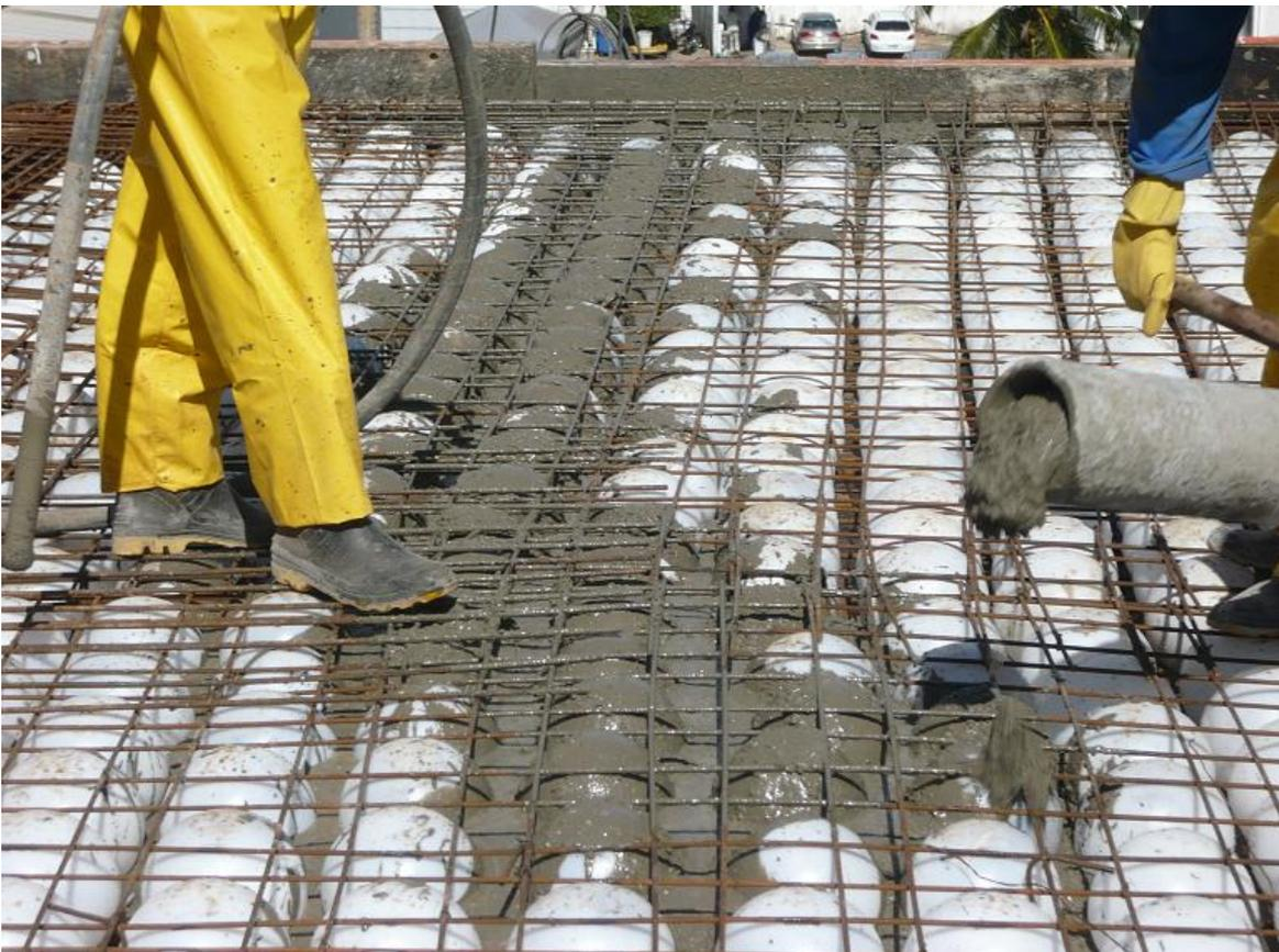
Figura 4.10 – Detalhe de erro de concretagem
