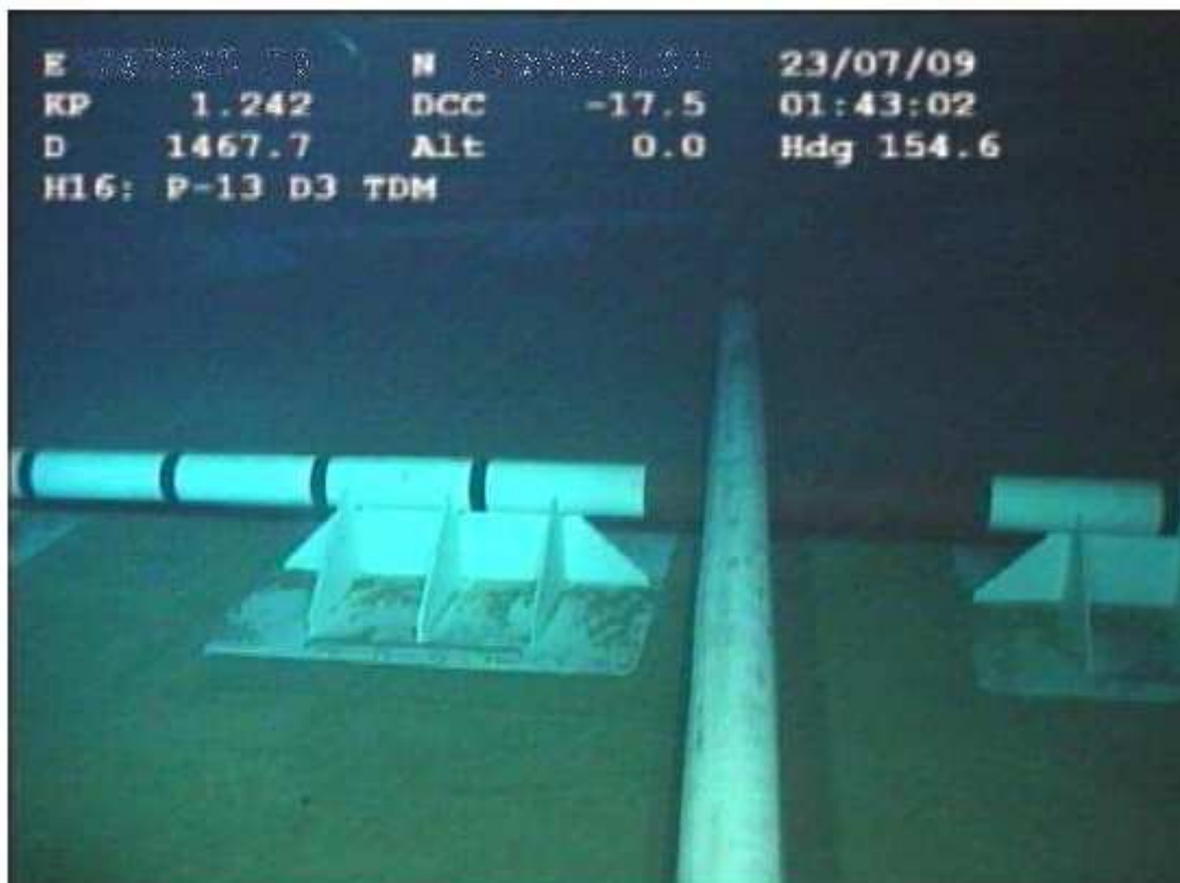
Figura VI-1 – Um duto cruzando dois sleepers - [6].
