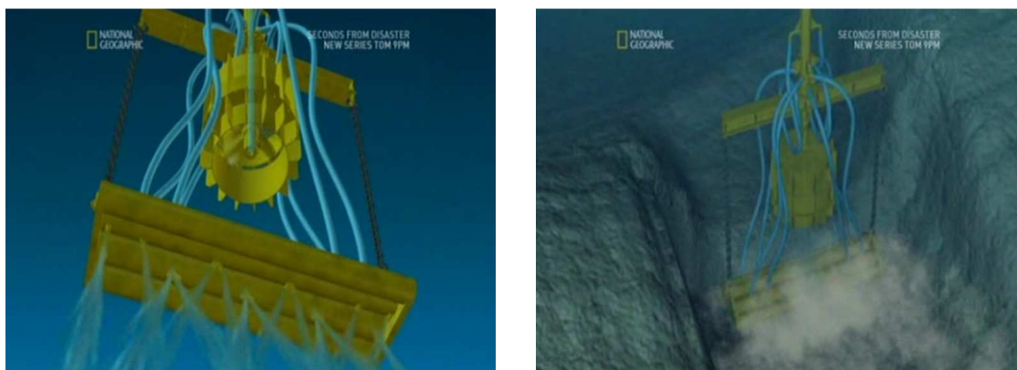
Figura VI-12 – Escavação de trincheiras em solos argilosos [12].
