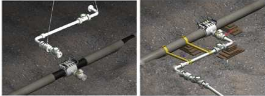
Figura II-3 – Troca de conexão em um sistema submarino - [10].
