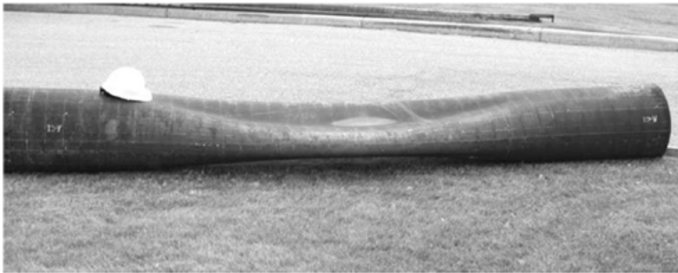
Figura II-10 - Duto que colapsou devido à pressão externa - [5].
