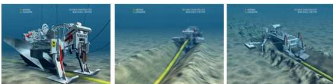
Figura VI-10 - Escavação e posterior preenchimento da trincheira para solos arenosos - [12].
