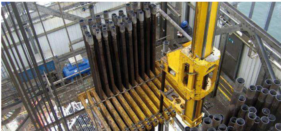
Figura 68 – Cavalete de tubos (fingerboard) com tubos estaleirados
