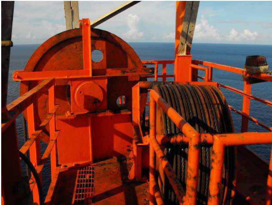
Figura 12 – Bloco de coroamento no topo da torre de perfuração de uma sonda ( http://i174.photobucket.com/albums/w117/yeti-monster/work/up%20the%20derrick%2017-08-09/DSCF3301.jpg )
