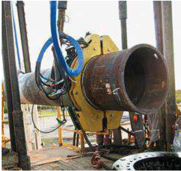
Figura 18 – Elevador preso a uma coluna de revestimento de 36” de diâmetro ( http://www.worldoil.com/uploadedimages/Issues/Articles/Dec-2011/WO1211-Rigs-Rig-Floor-Franks1.jpg )
