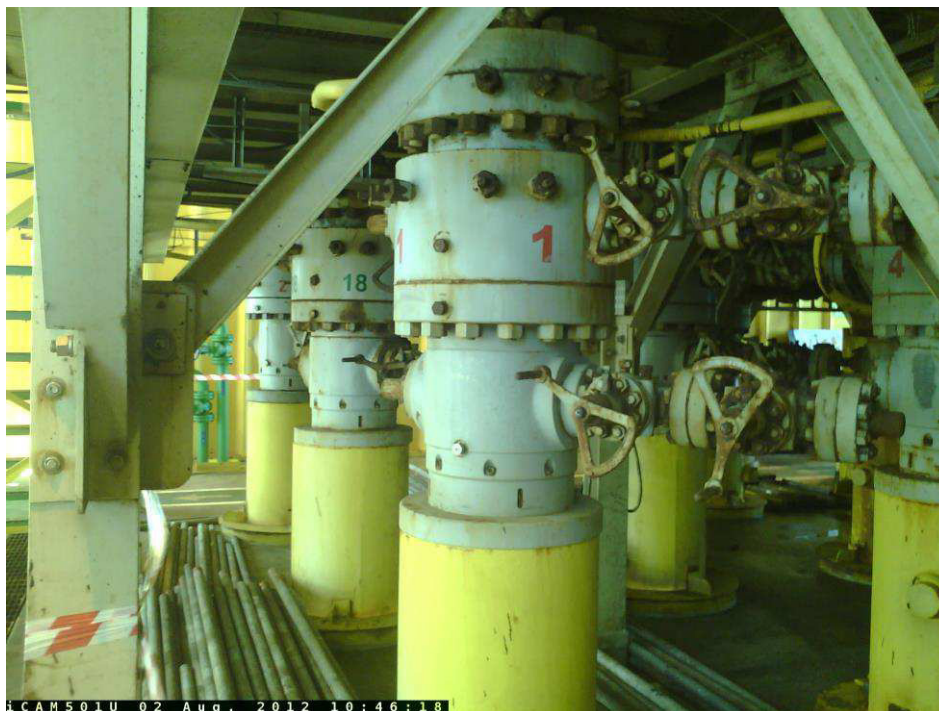
Figura 62 – Cabeça de poço de um sistema de completção seca (Acervo do autor)
