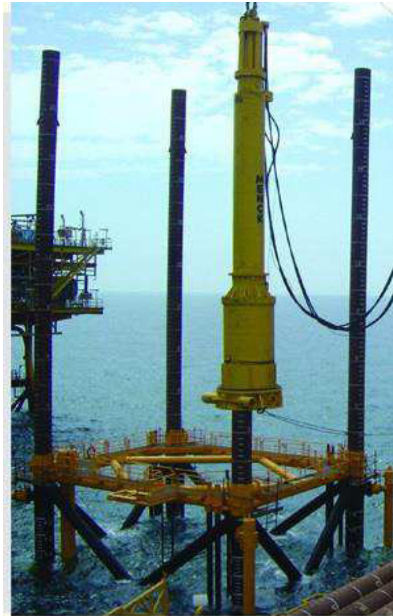
Figura 66 – Martelo hidráulico do modelo Menck MHU 270t, mais utilizado para aplicações offshore. ( http://en.dot-corp.ir/equipment/view/1 )
