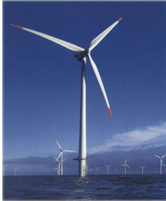
Figura 2.3: Turbina eólica de eixo horizontal
