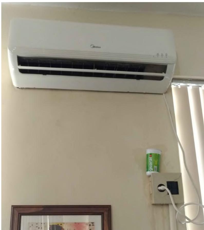
Figura 1: Ar condicionado pingando e copo sobre a tomada para coletar a água.
