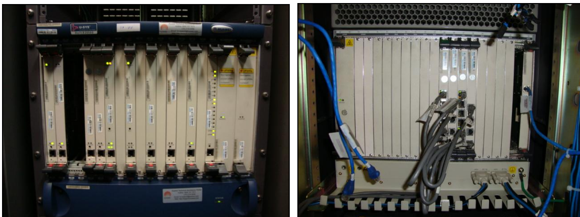
Figura 4.6: Imagem frontal e traseira do Softswitch
