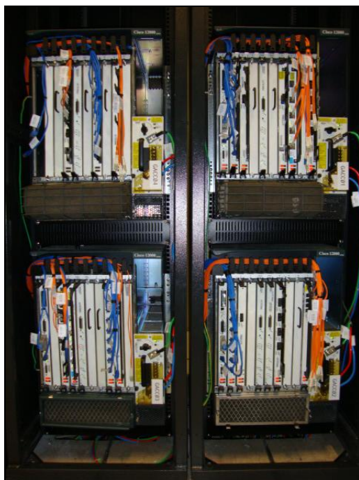
Figura 4.5: Conjunto de roteadores de Acesso do Backbone IP do CRT
