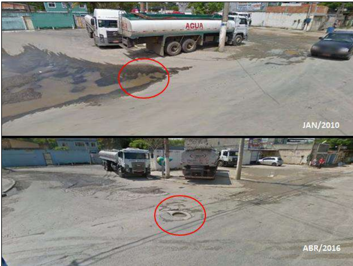
Figura 43: Caso de bueiro sem tampa
