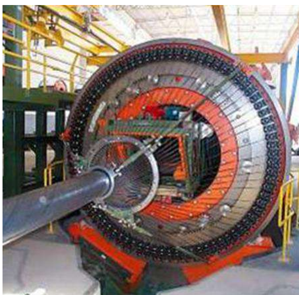
Figura 2.7 - Assentamento das armaduras de tração (BARTELI, 2017)
