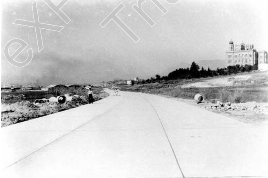
Figura 2 – Avenida Brasil recém inaugurada e com tubulações para obras de drenagem ainda expostas, trecho próximo a Fundação Oswaldo Cruz.
