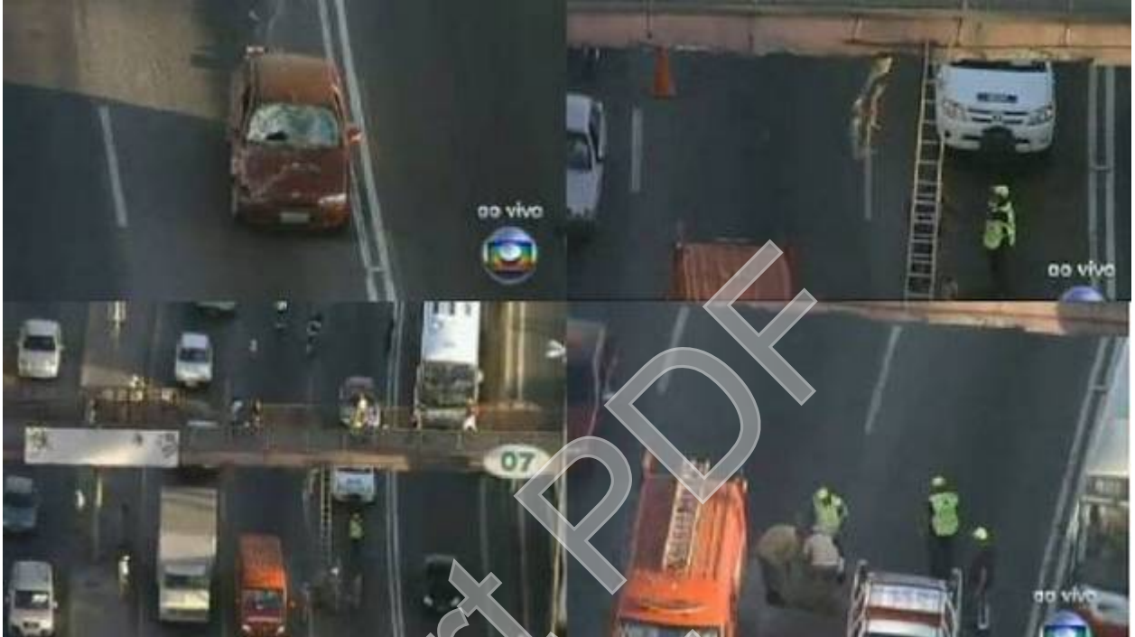
Figura 6 – Carro atingido por pedaço de reboco da passarela 7 da Avenida Brasil.
