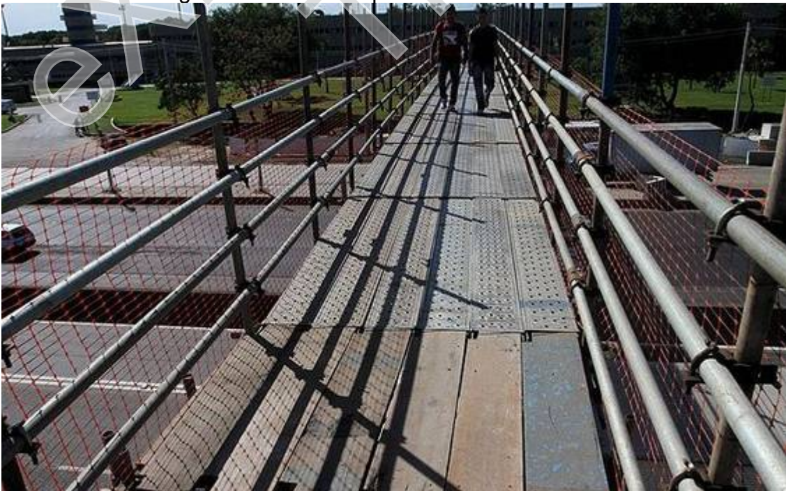
Figura 9 – Passarela provisória alvo de críticas.
