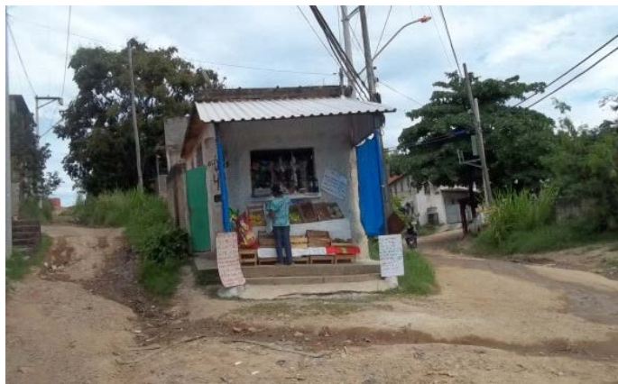
Figura 07 - Rua Olívia Lopes - Bairro Arsenal (Via sem pavimentação)
