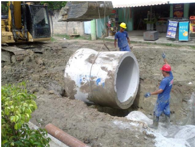
Figura 14 - Instalação de Rede Pluvial no Bairro do Arsenal
