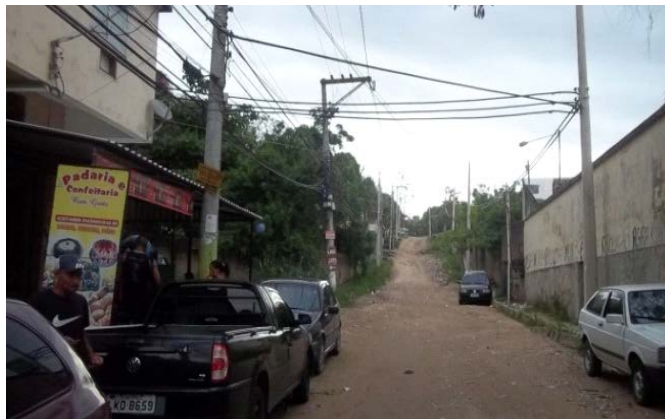
Legenda: Ausência de pavimentação nas ruas de acesso ao empreendimento Fonte: Acervo Pessoal Pesquisa de Campo 17 e 18 de janeiro de 2013
