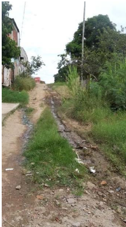
Figura 11 - Rua: Olívia Lopes, Bairro do Arsenal (Vazamento de água e esgoto do empreendimento Arsenal Life I)
