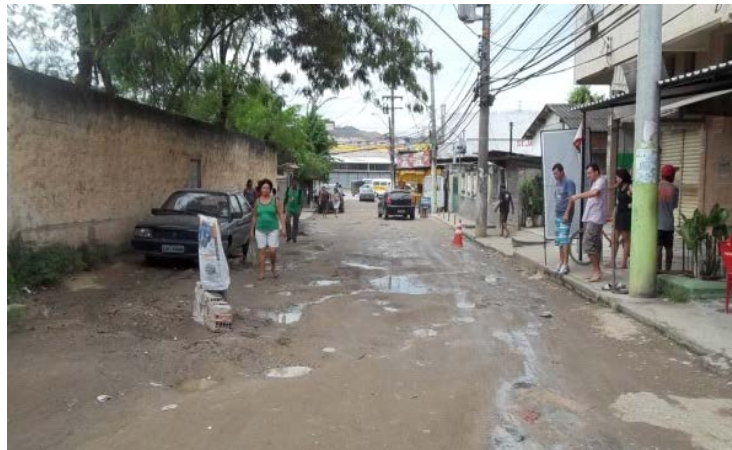
Figura 06 – Rua Olívia Lopes - Bairro Arsenal (Via sem pavimentação)
