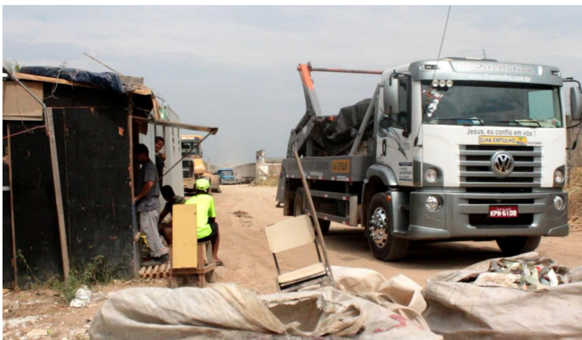
Foto retirada na visita à Acex (Fev. 2014): Acesso das caçambas de entulho. À esquerda, Docinho, dentro do contêiner de fiscalização, observa o momento da foto.
