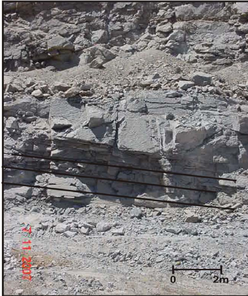
Foto10: Fraturas sub-horizontais a cerca de 90m de profundidade.
