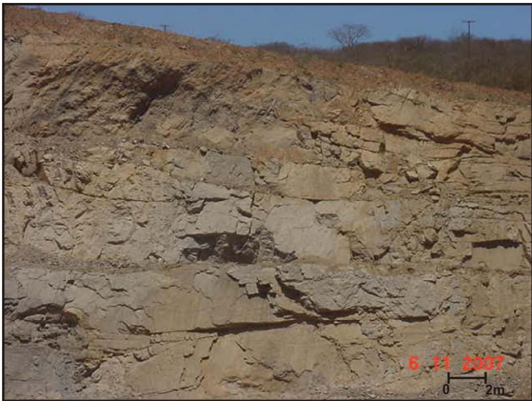
Foto 04: Fraturas sub-horizontais que interceptam e conectam as outras estruturas. Cava da mina.
