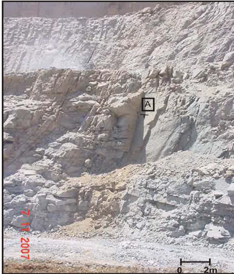
Foto 09: Plano de falha(A) interceptado por fraturas sub-horizontais.
