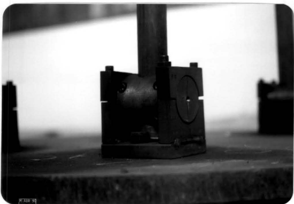
FOTO III.2 - Vista da fixação dos apoios à perna do protótipo
