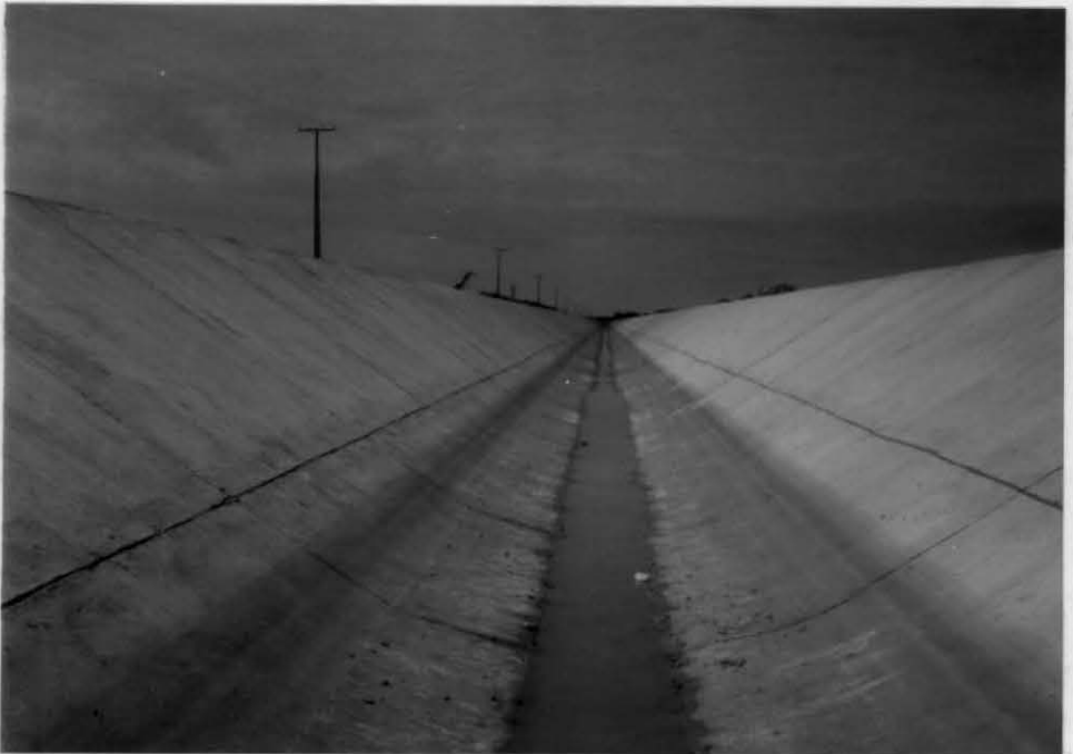
Fotografia III.2a - Canal principal já executado.
