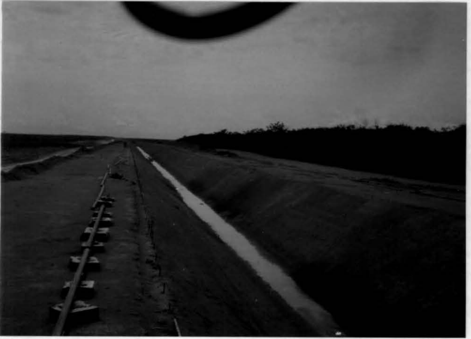
Fotografia III.1a - Canal principal antes da colocação do revestimento.
