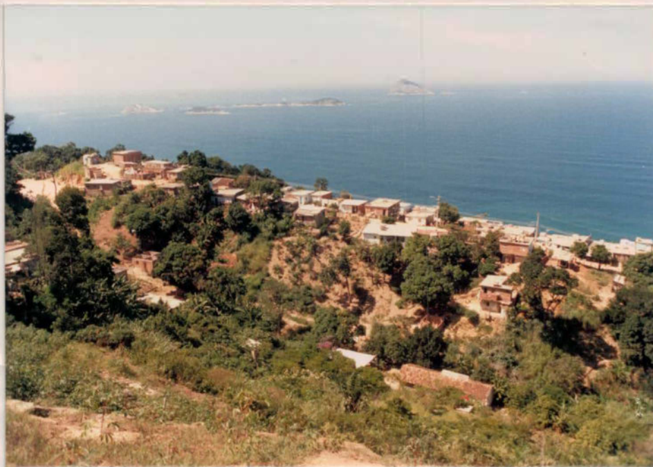
FOTO 6 - Vista da parte alta do Sobradinho tomada da encosta do Morro Dois Irmãos. Notar a baixa densidade da ocupação.
