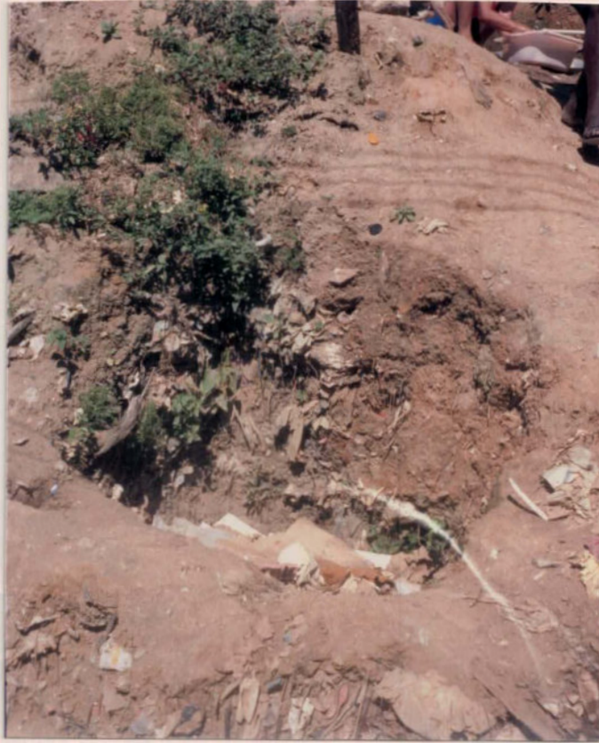
FOTO 31 - Escavação em mistura de solo e lixo (solo antropológico).
