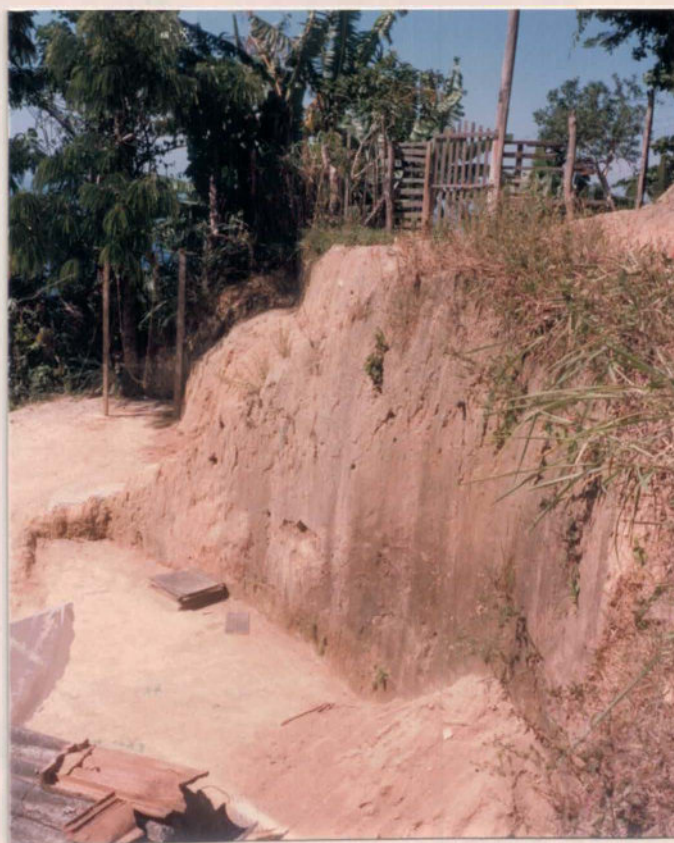
FOTO 26 - Corte vertical na unidade residual saprolítico, que mostra boa resistência.
