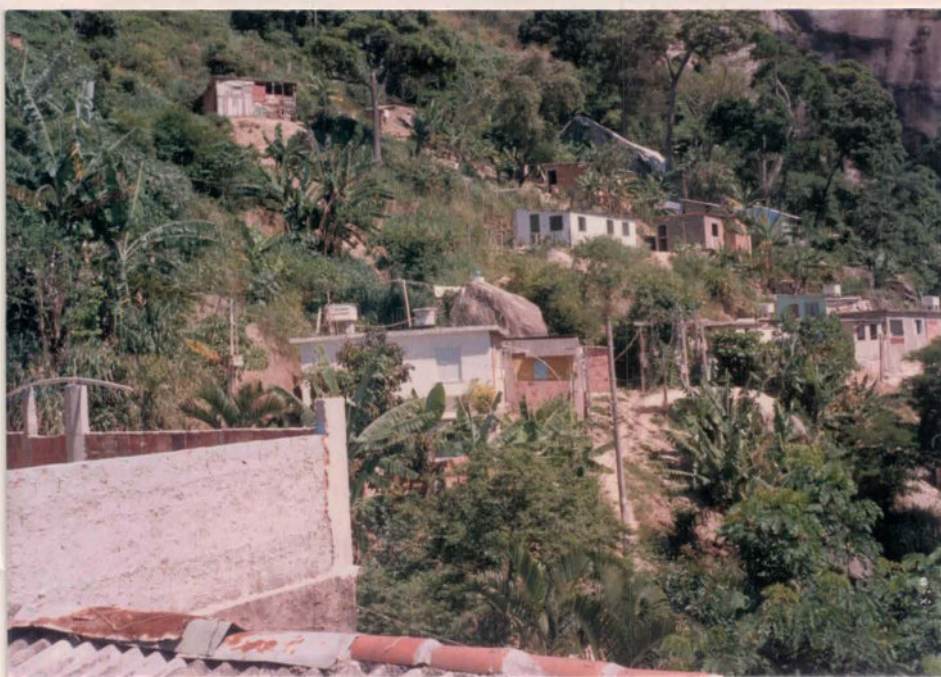
FOTO 4 - Vista da encosta na região da Rua 25 de Dezembro.
