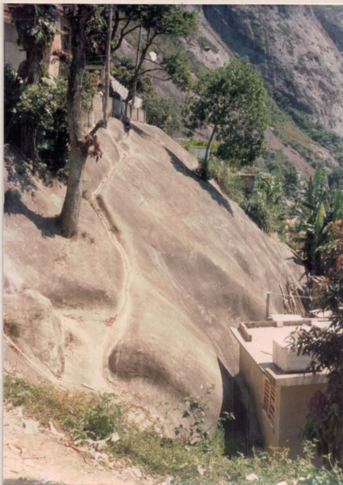
FOTO 33 - Obra em concreto projetado na Rua 31 de Julho.
