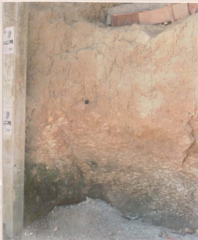
FOTO 22 - Unidade colúvio/residual mostrando o contato brusco entre os diferentes materiais.
