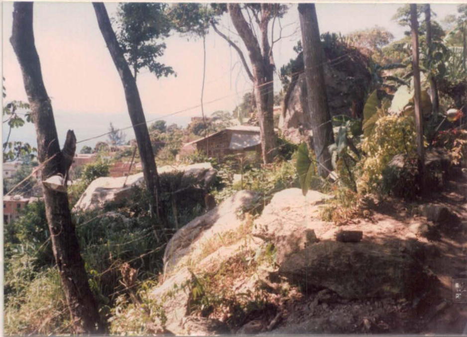
FOTO 12 - Blocos rochosos componentes do depósito de talus na região da Rua 25 de dezembro.
