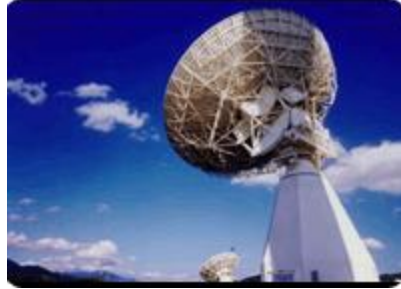
Figura 1. Antena Tanguá (Estação Terrena de Tanguá)
