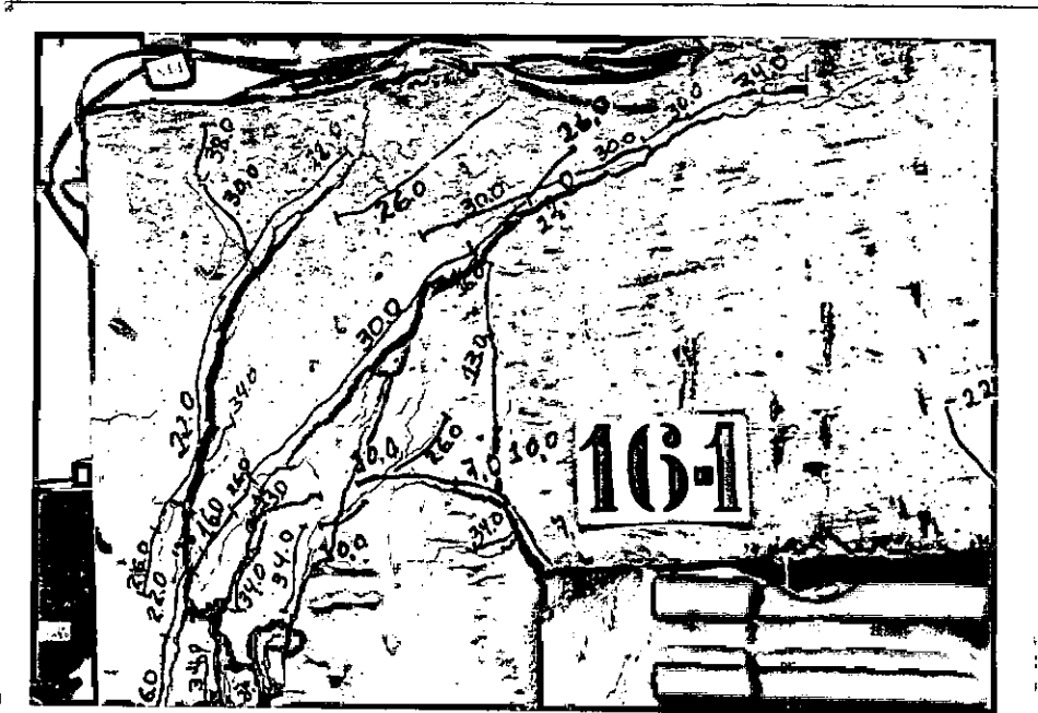
FIGURAS A.34 E A.35 - EVOLUÇÃO DAS FISSURAS E CONFIGURAÇÃO DE RUP-TURA DO MODELO 16.
