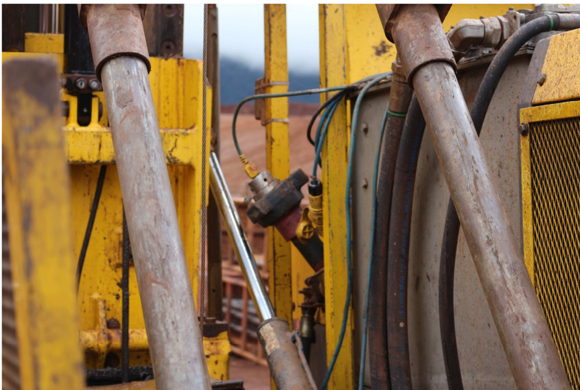
Figura 7.11 - Sensor de contrapressão instalado no registro do alimentador do fluido (Fonte: o autor)
