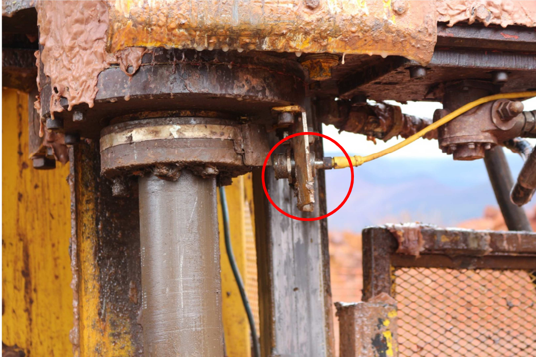
Figura 7.31 – Fotografia evidenciando o sensor de rotação fora da direção do objetivo instalado no mandril da sonda (Fonte: o autor)
