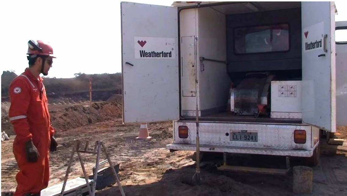
Figura 2.2 – Perfilagem geofísica em furo de sondagem rotativa (Fonte: acervo Vale / Klayton Ferreira)
