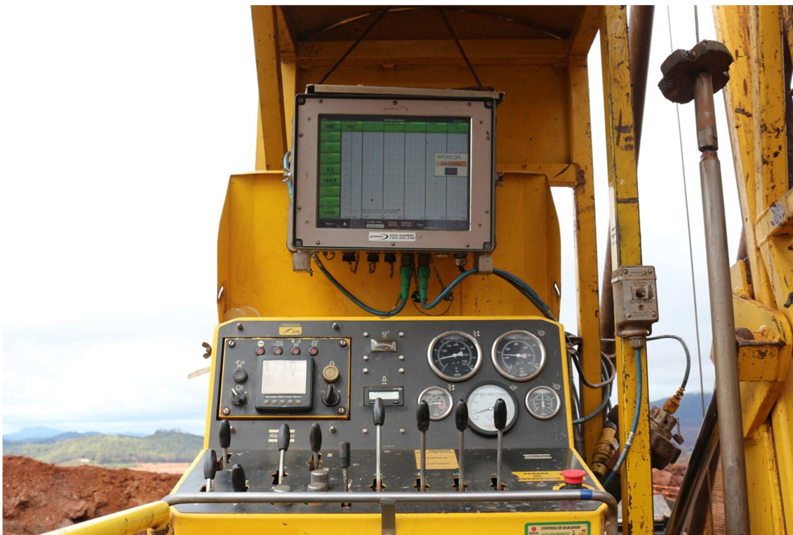
Figura 1.1 - Sistema EDR instalado em Sonda CS14. (Fonte: PASON – EDR – o autor)
