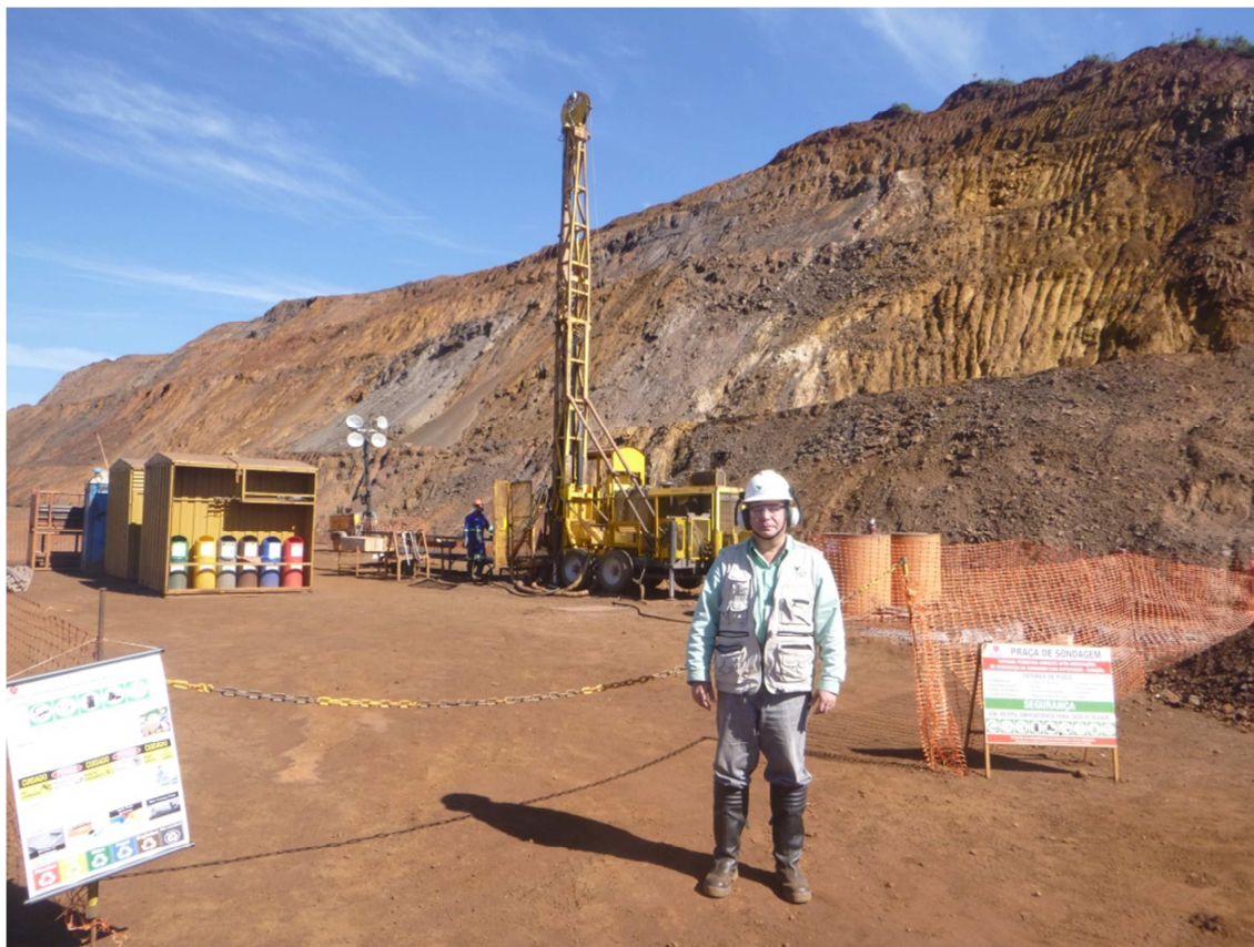
Figura 4.8 - Praça de Sondagem (Fonte: o autor).
