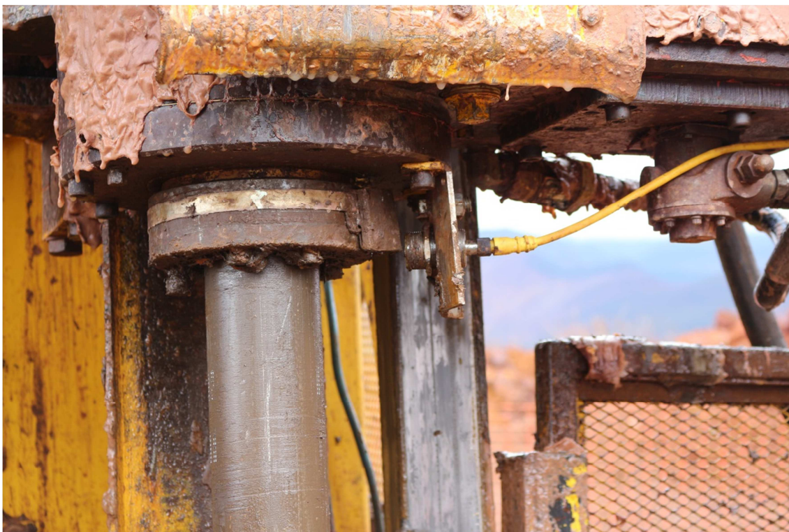
Figura 7.9 - Sensor de rotação instalado no mandril da coluna de perfuração (Fonte: o autor)
