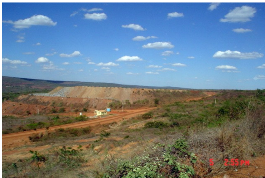
Figura 32 – Pilha de disposição de estéril/rejeito. Fonte: INB (2005).
