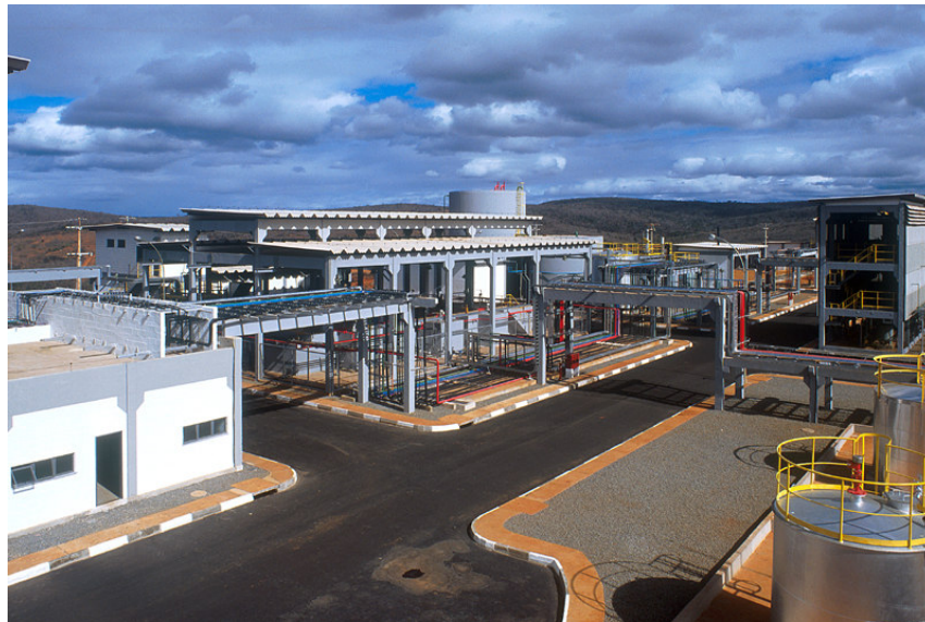
Figura 21 – Vista geral da usina de processamento químico do minério. Fonte: INB (2005).
