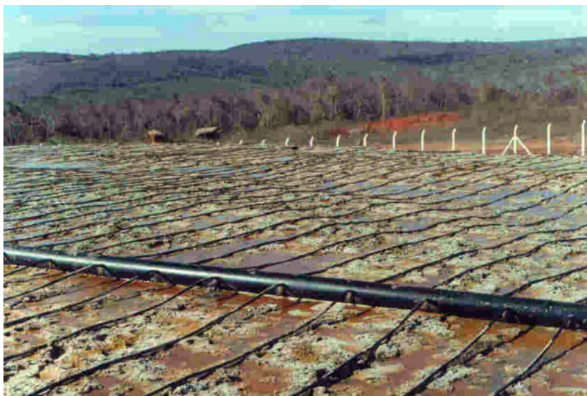
Figura 19 - Tronco irrigando a pilha de lixiviação com ácido sulfúrico. Fonte: (INB, 2003).
