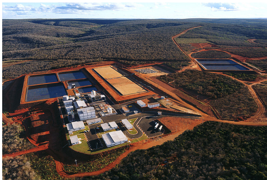
Figura 10 - Vista aérea das instalações de concentração de urânio. Fonte: INB (2001).
