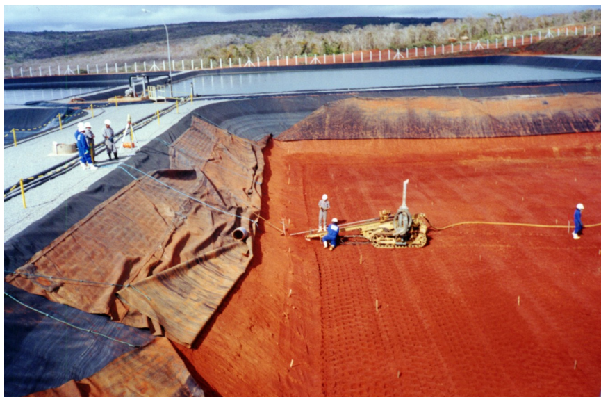
Figura 22 – Construção das bacias de disposição de líquidos, terraplenagem. Fonte: (INB, 2001).
