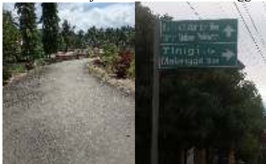
Gambar 5. Kondisi jalan menuju Desa Malangga
