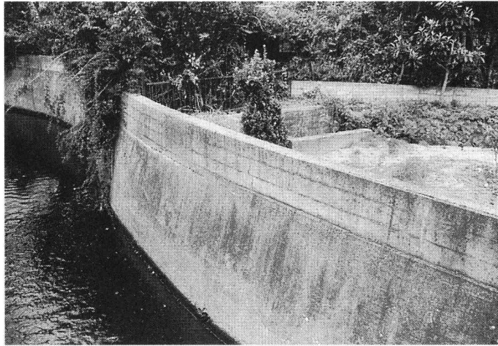
写真2 六ヶ郷用水（右奥）と中沢川（堰）（左手前）の交差
