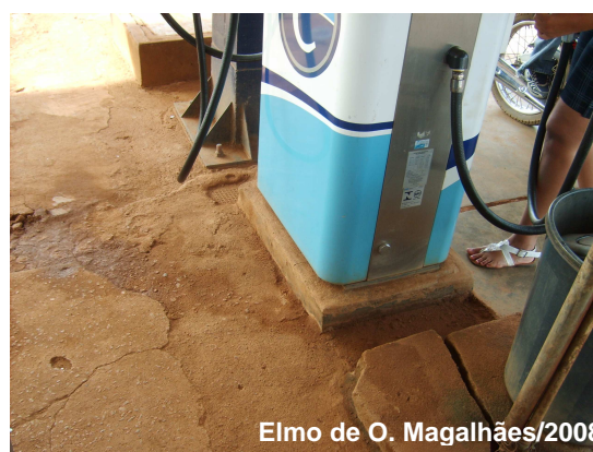
Figura 40: (a) Bomba de combustível operando sem ilha de contenção; (b) Bomba com ilha de contenção e piso fora das especificações
