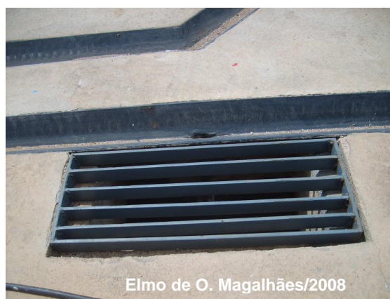
Figura 41: Sistema de canaleta dentro das especificações
