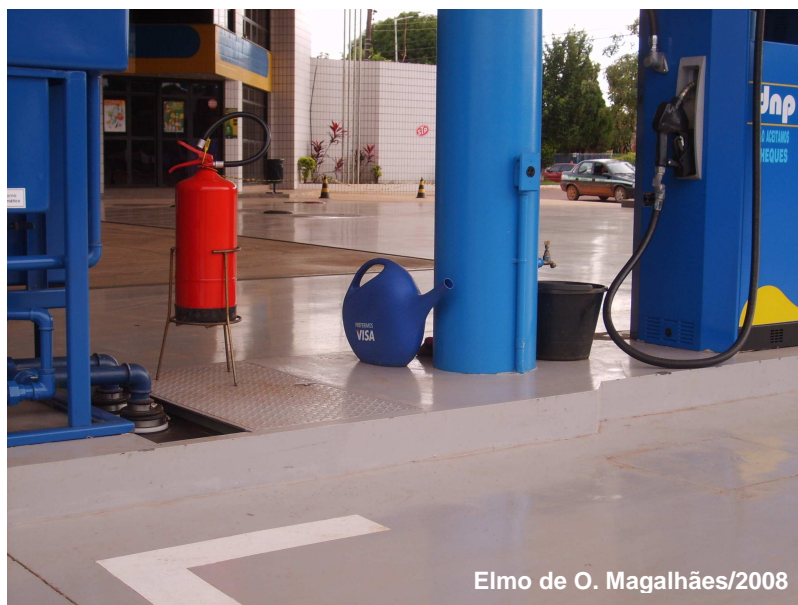
Figura 35: Piso na área de abastecimento dentro das especificações
