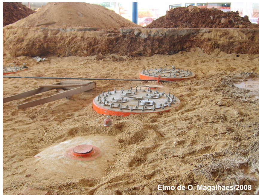
Figura 13: Tanques ecológicos encobertos até o nível para instalação dos reservatórios de contenção
