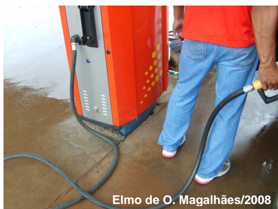
Figura 40: (a) Bomba de combustível operando sem ilha de contenção; (b) Bomba com ilha de contenção e piso fora das especificações
