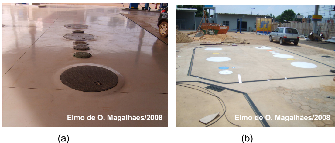
Figura 37: Áreas de abastecimento nos PRCs (a) Área de descarga padronizada; (b) Área de descarga padronizada em construção, com canaletas corretamente instaladas
