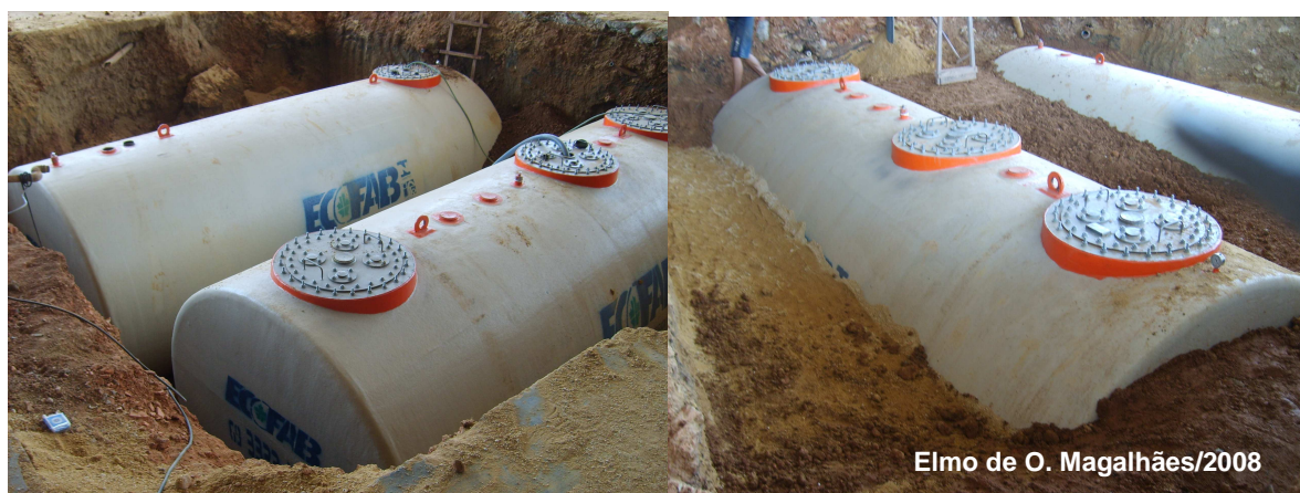
Figura 11: Tanques ecológicos posicionado para instalação
