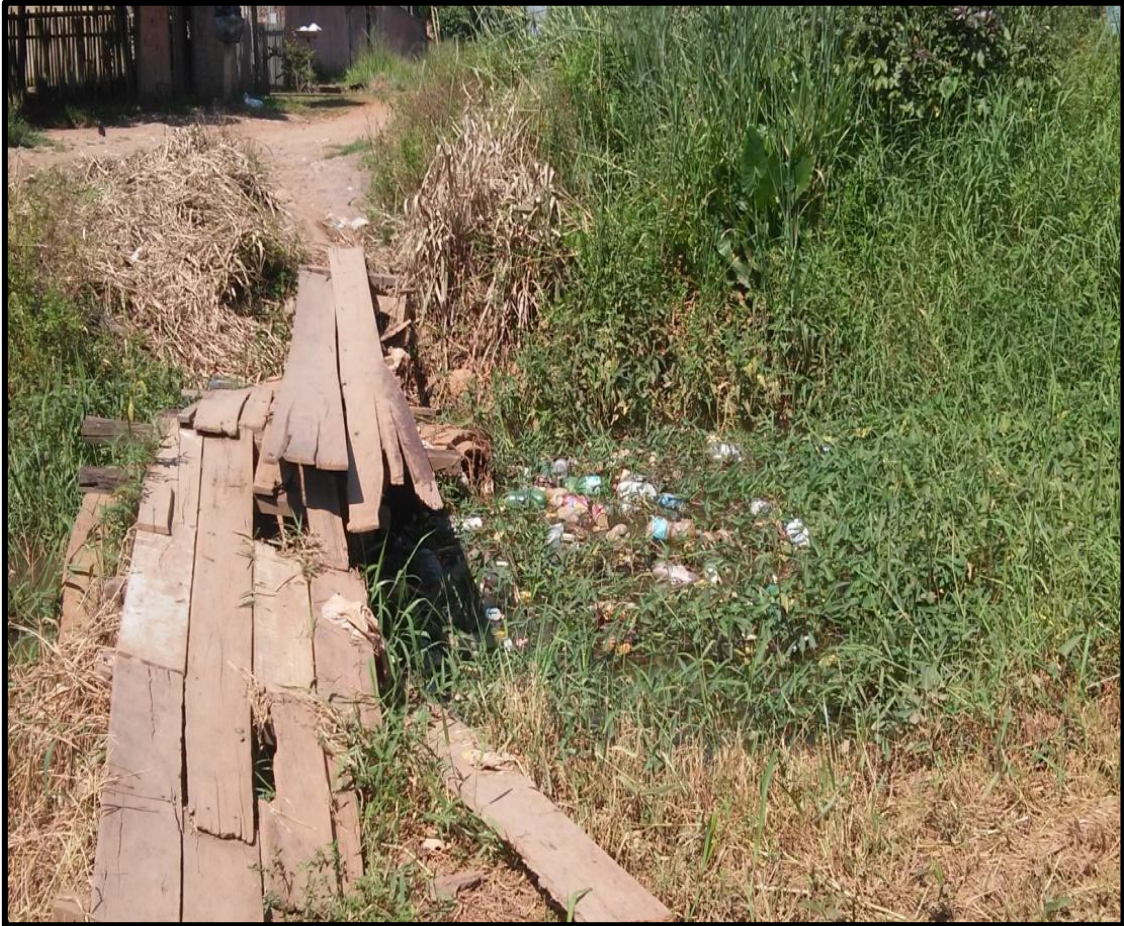
Figura 15: Rua Moinho dos Ventos, bairro São Francisco. Observa-se a presença de uma ponte mal construída que dá acesso aos moradores de um lado para o outro, com muita quantidade de lixo no entorno do canal. Foto tirada por Silva em 04/11/2014.
