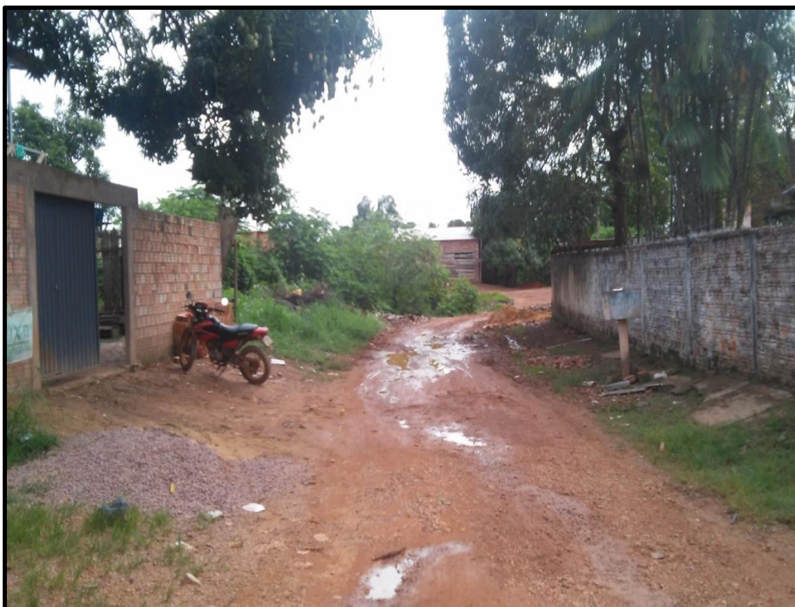
Figura 22: Rua Teotonio Vilela, bairro JK. Observa-se a má condição da rua. Foto Tirada por Silva, em 04/12/2014.
