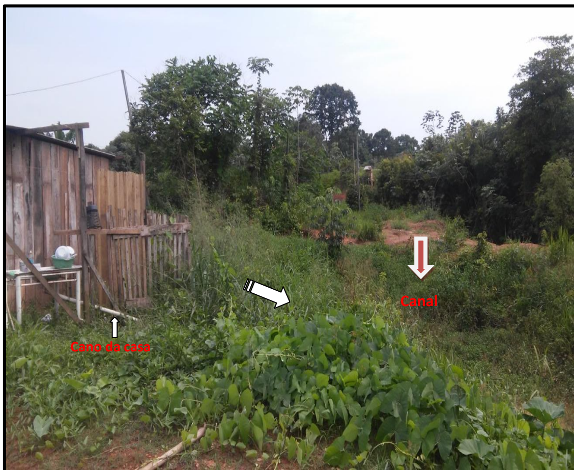
Figura 28: Rua Teodoro Lopes, bairro Mariana. Observa-se que a casa encontra-se suscetível ao deslizamento por ser construída a margem do canal. Foto: Silva, tirada em 31/10/2014.
