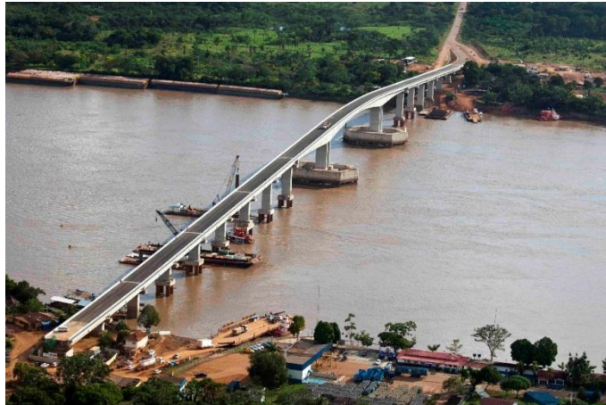
Fotografia 25 – Ponte sobre o rio Madeira. Porto Velho/RO.
