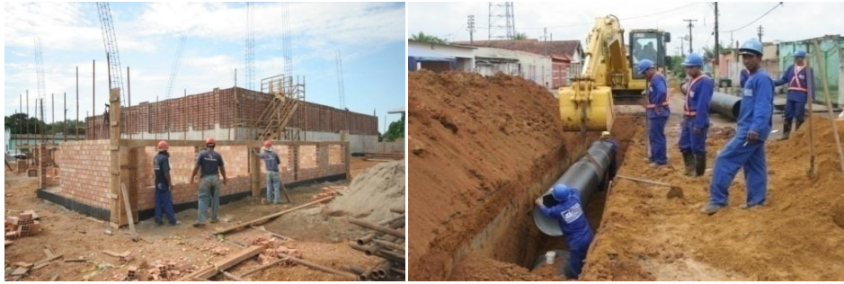
Figura 9 - Obras Plano de Aceleração do Crescimento - PAC
