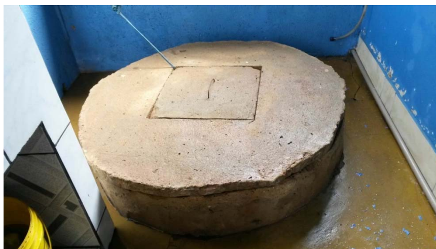
Foto 10: Poço cacimba protegido e profundidade superior a 15 metros Autor da foto: Charlles da Silva Barata
