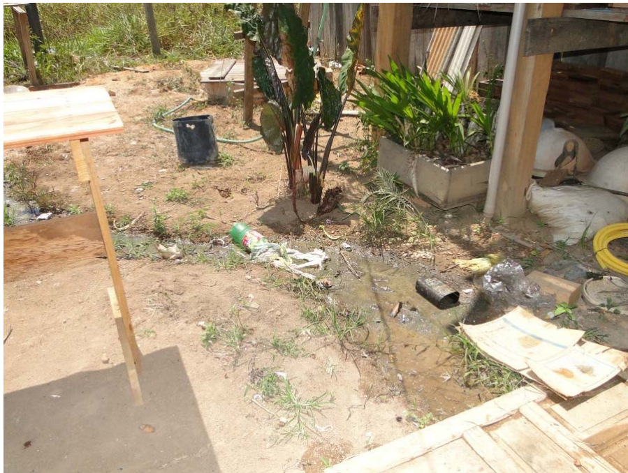
Foto 5 – Contaminação de água superficial, escoando a céu aberto a montante do poço. Autor da foto: Charlles da Silva Barata
