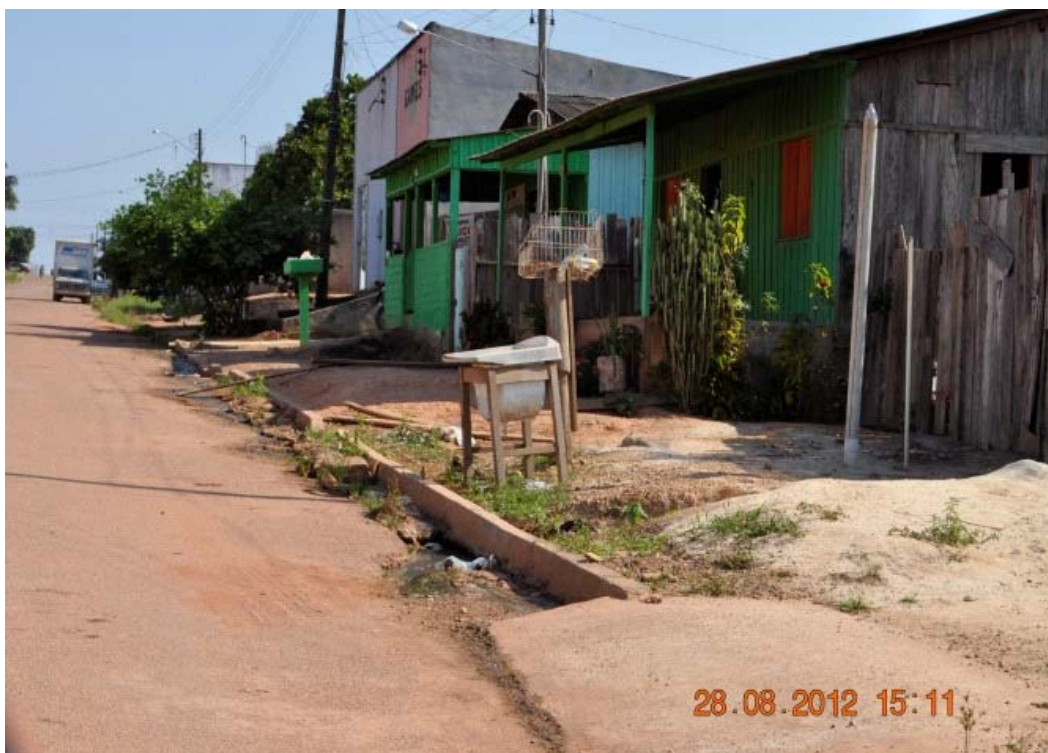
Foto 01: Vala negra com escoamento do esgoto a céu aberto
