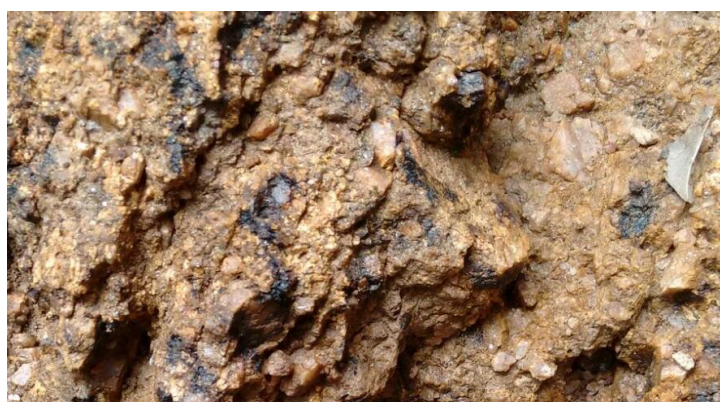
Foto 9 – Litologia da parede na incisão erosiva Fonte: Autora (2015)
