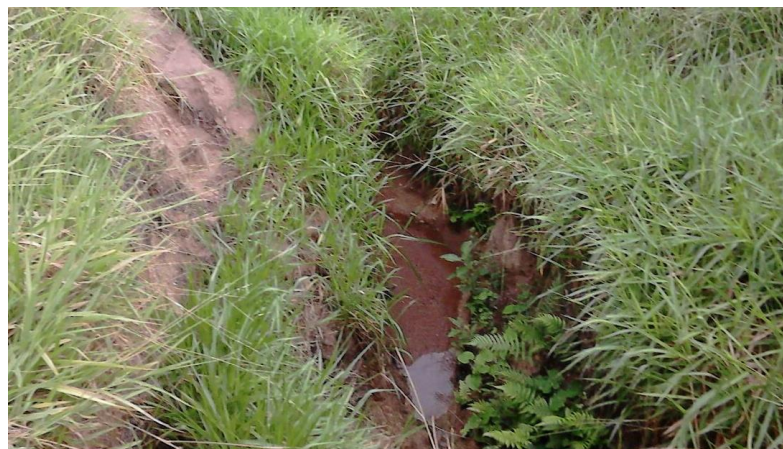
Foto 4 – Afloramento do lençol freático na incisão erosiva.
