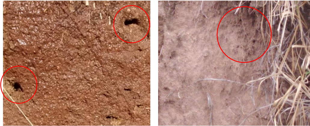
Foto 5 – Piping na região da cabeceira.
