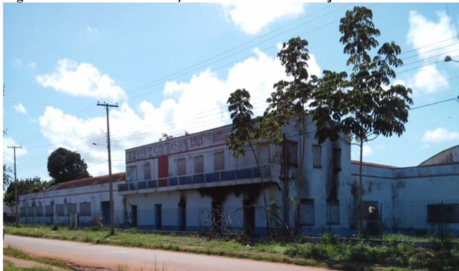
Figura 40 – Prédio das instalações da RONDEX em Guajará-Mirim
